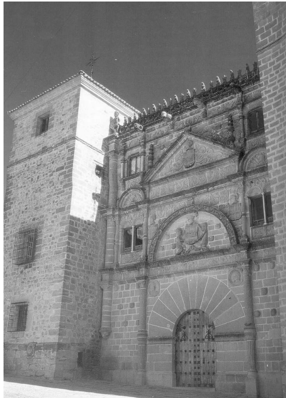
Fig. 2. Fachada Casa de las Torres a finales del siglo xx.
