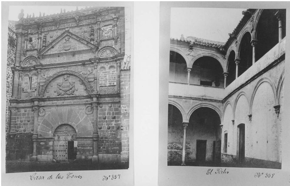
Fig. 15. Casa de las Torres hacia 1915.
