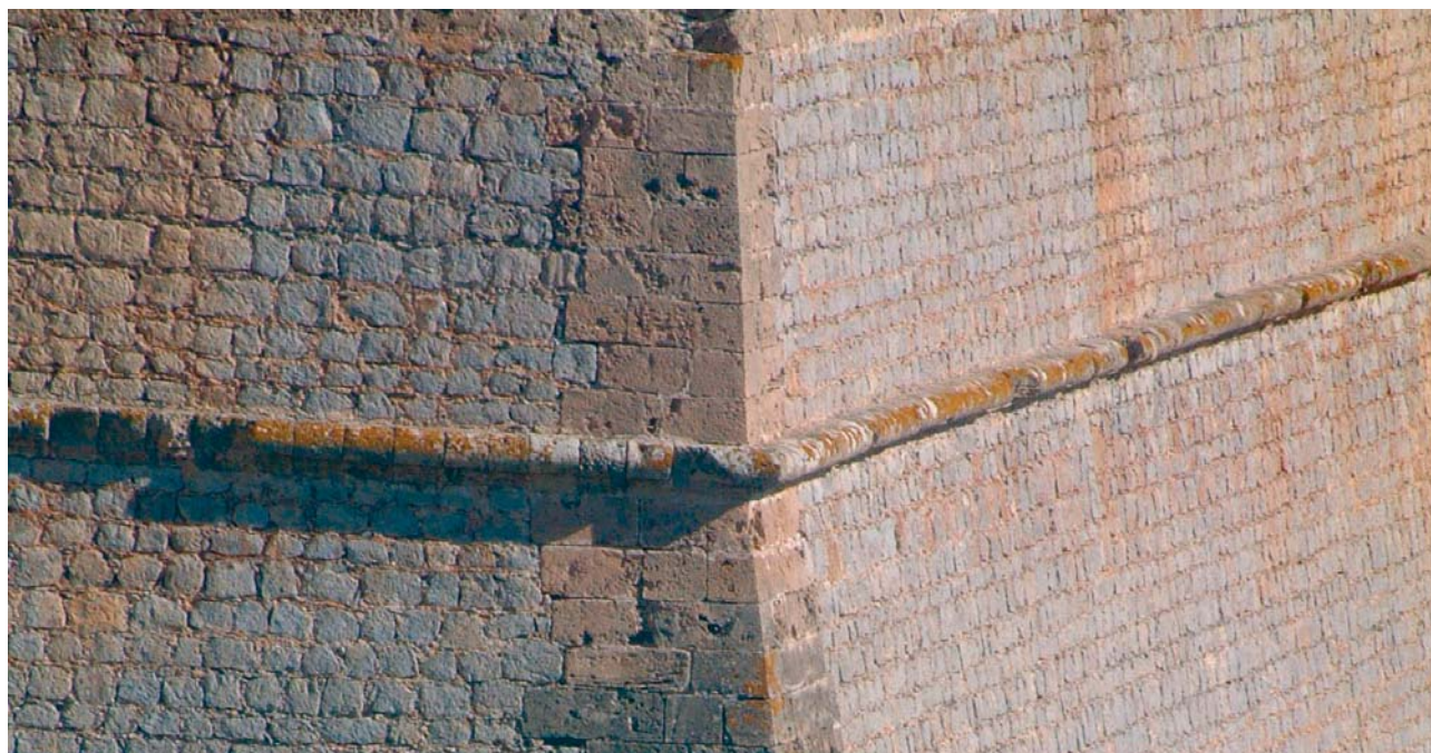
FIGURA 64 Detalle de cantonera y cordón de un baluarte de Calvi Eivissa
