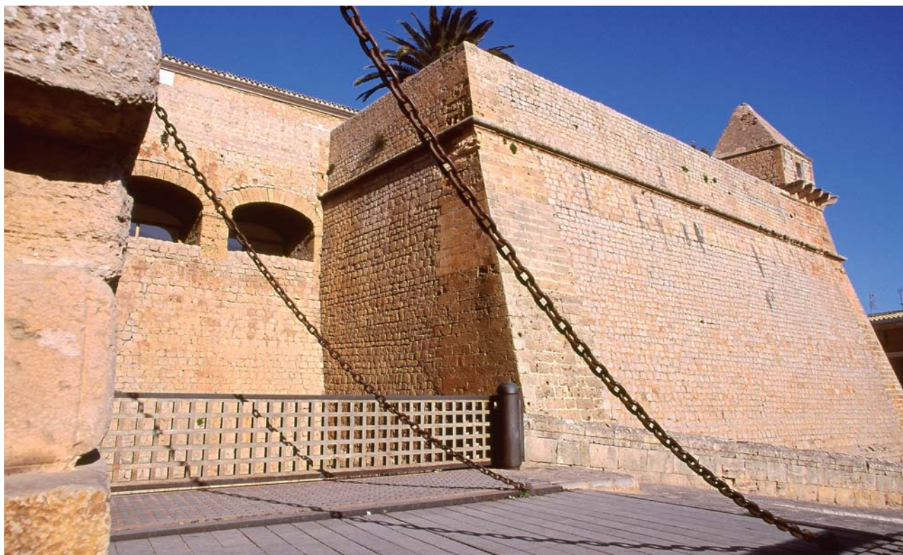
FIGURA 93 Casamata y flanco del baluarte de Sant Joan Eivissa
