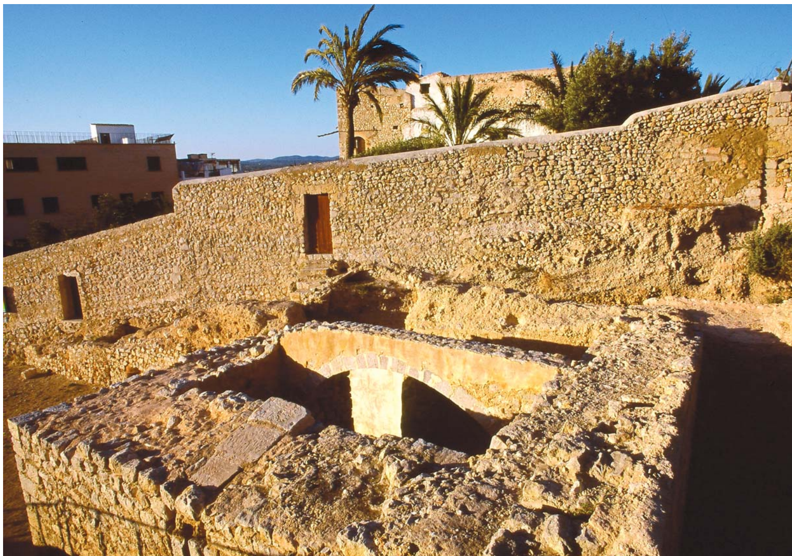
FIGURA 21 Torre XXV de la muralla medieval Ronda Calvi, Dalt Vila
