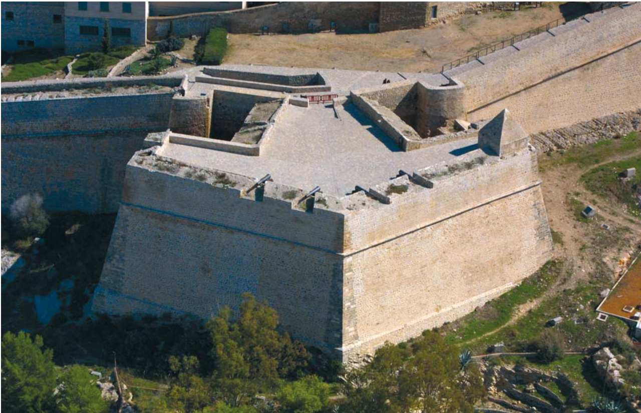
FIGURA 65 Detalle de cantonera y cordón de un baluarte de Calvi Eivissa
