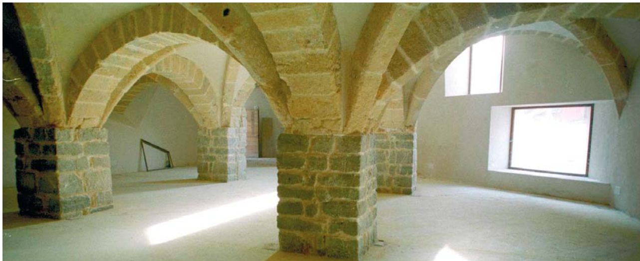
FIGURA 68 Interior de la Sala de ses Voltes Casa de la Ciutat, en el castillo Dalt Vila, Eivissa
