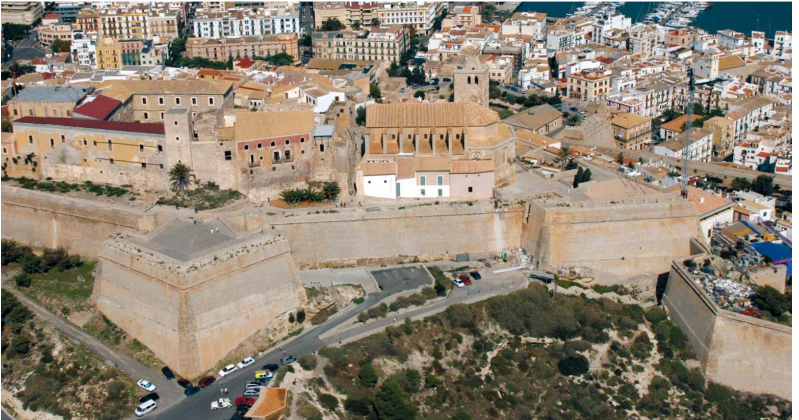
FIGURA 60 Baluarte de Sant Jaume, alineada su cara con la casamata del baluarte de Sant Pere, cuyas troneras deben cubrirla Eivissa
