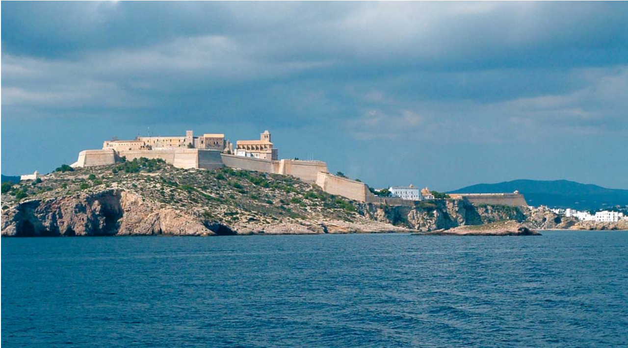
FIGURA 69 Frente fortificado de levante. De izq. a dcha.: baluartes de Sant Jordi, Sant Bernat, Santa Tecla, Es Revellí y Santa Llúcia Eivissa
