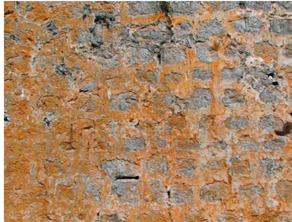
FIGURA 12 Detalle de la mampostería de piedra caliza de la muralla de Eivissa
