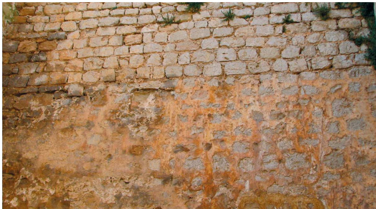
FIGURA 13 Detalle de paramentos con y sin rejuntado Eivissa
