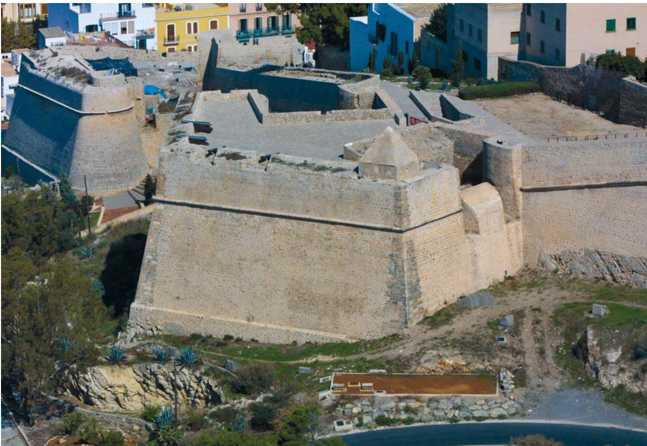
FIGURA 60 Baluarte de Sant Jaume, alineada su cara con la casamata del baluarte de Sant Pere, cuyas troneras deben cubrirla Eivissa
