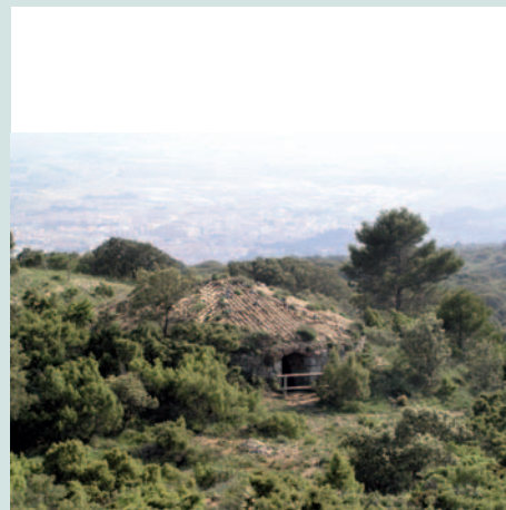
Pou del Canyo (lbi). Construcció que manté la coberta de teules.
