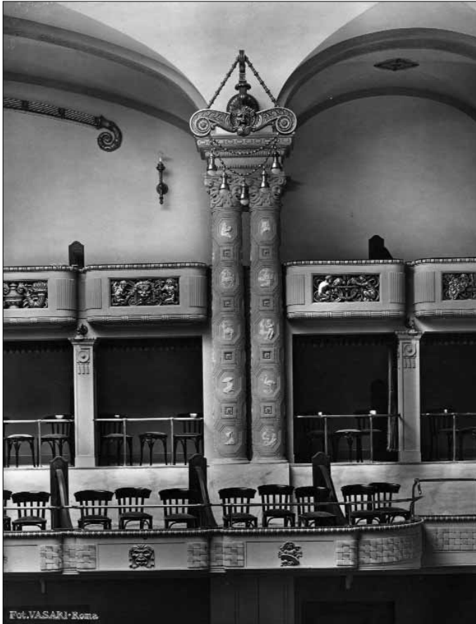
Fig. 10. Firenze, M. Piacentini, Cinema teatro Savoia (después Odeon); detalle de la sala con las columnas pareadas y la lámpara balcón (foto R. Vasari, Università di Firenze, Biblioteca di Scienze Tecnologiche / Architettura, Fondo Papini).
