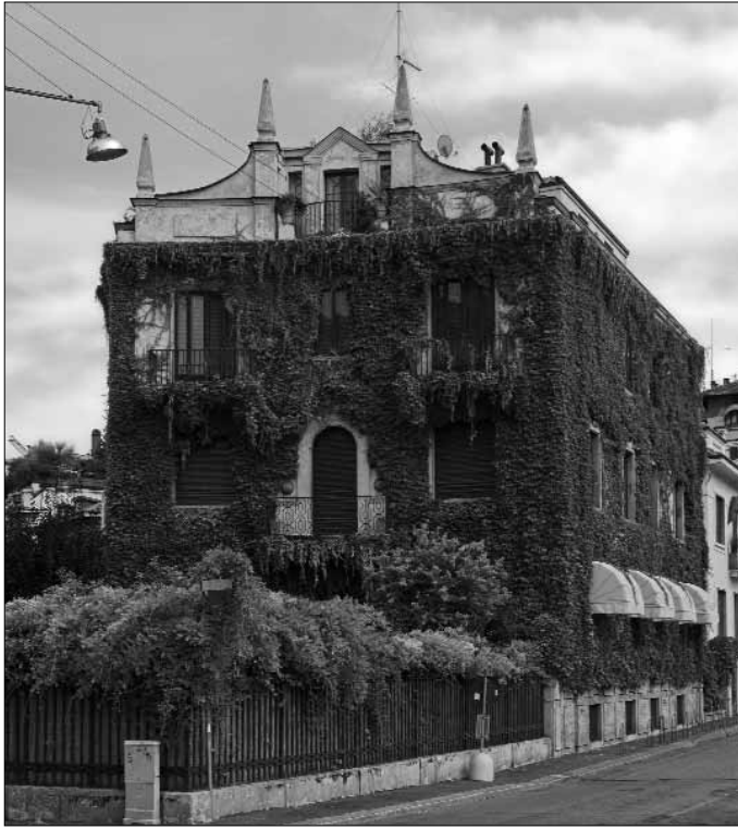
Fig 14. Immeuble rue Randaccio 9, Giò Ponti 1924-1926.
