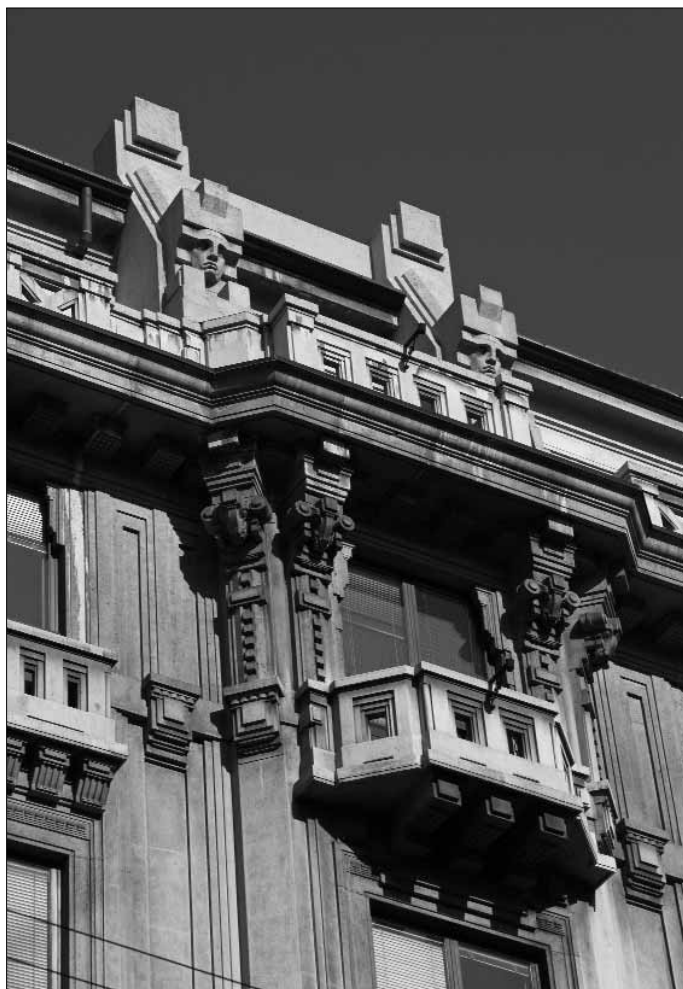
Fig. 20. Immeuble en rue Carducci, 14 – ing. C. Urbano, 1924.
