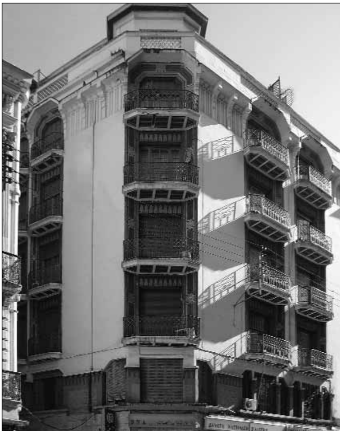
Fig 5. Immeuble, rue Didouche Mourad, (architecte Paul Guion).
