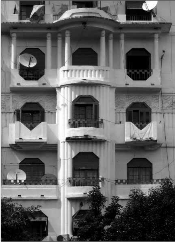
Fig 8. Detail immeuble, rue Didouche Mourad, parc Liberté.
