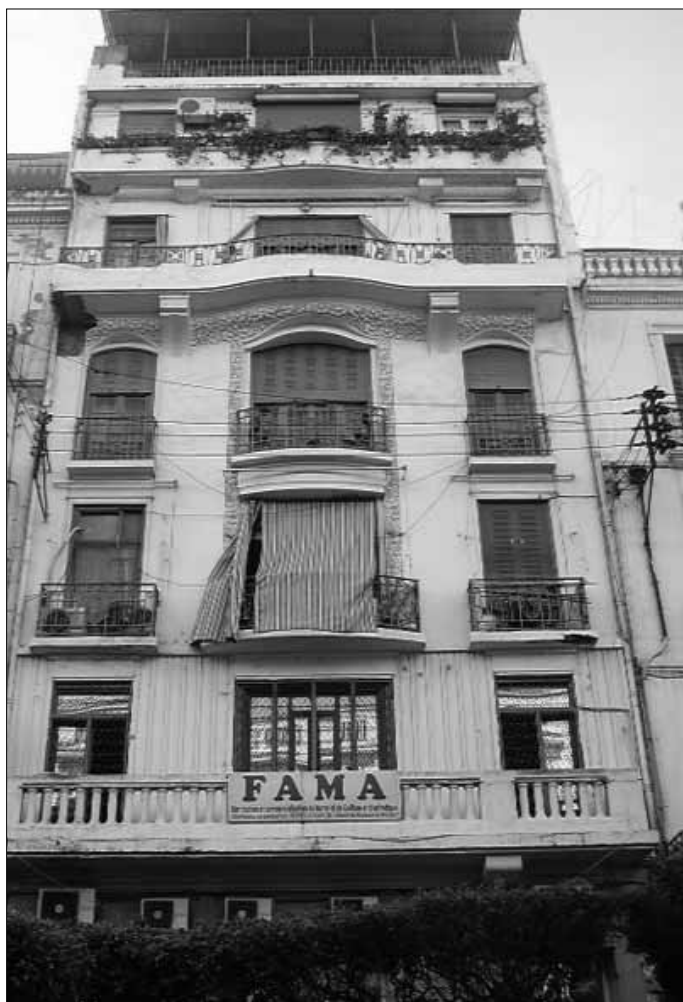
Fig. 18. Immeuble, rue Didouche Mourad.
