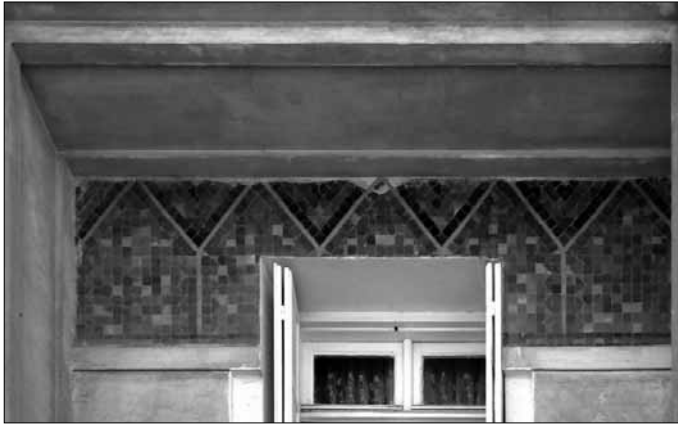
Fig. 19. Detalle del edificio Ugazio.
