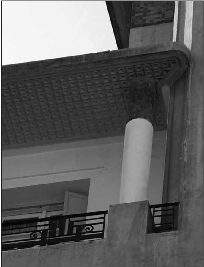
Fig. 18. Detalle del edificio Ugazio.
