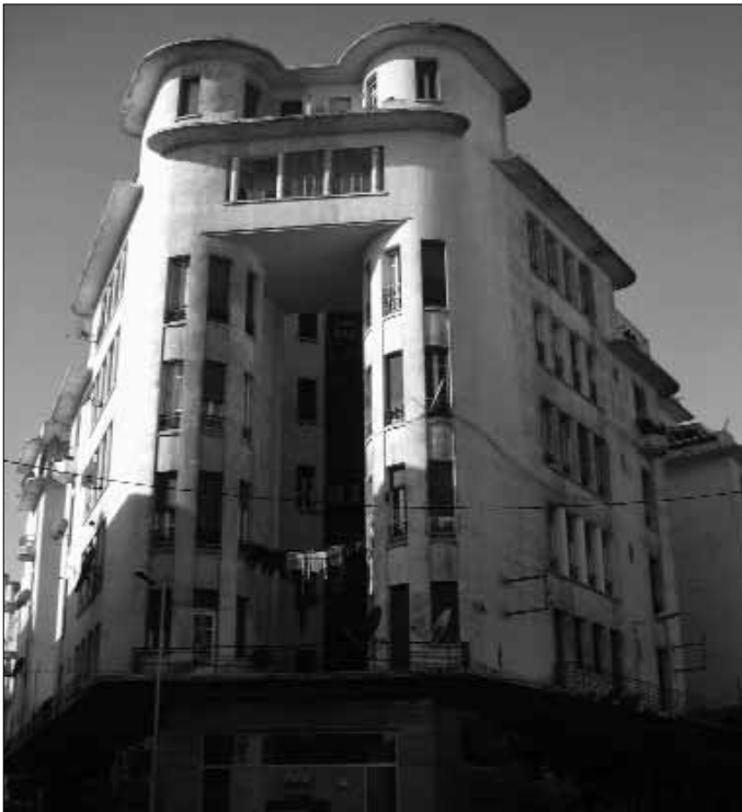
Fig. 24. Edificio Levy Bendayan.
