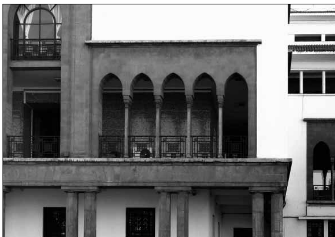
Fig. 9. Hotel de ville, detalle de fachada.
