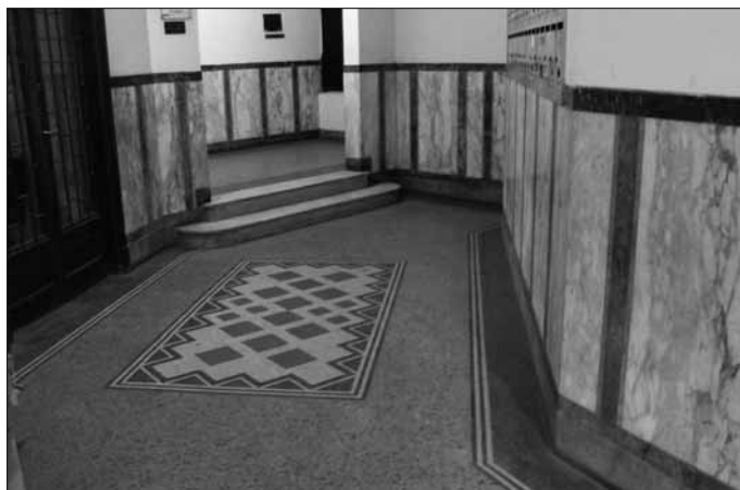
Fig. 33. Detalle pavimento interior.
