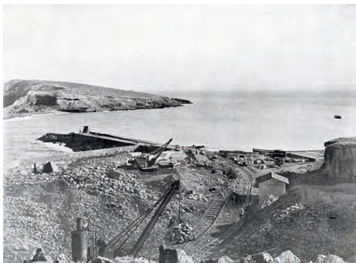
Avance de las obras del muelle de unión. Dique Noroeste, Memoria de la Junta del Puerto, 1909.
