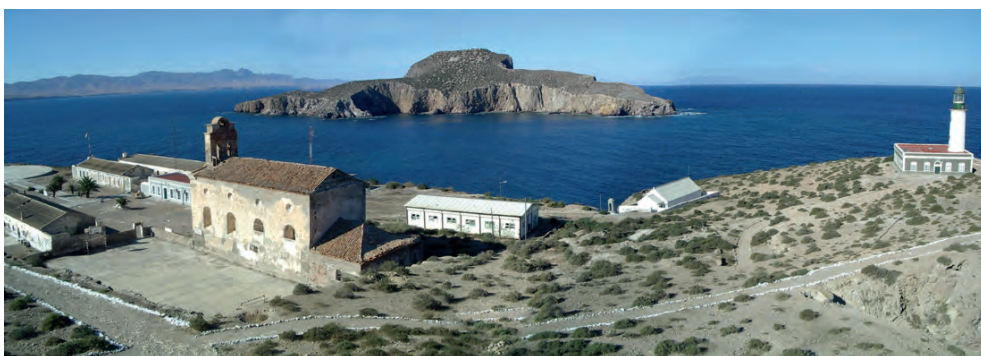
Vista general del extremo noroeste de la isla de Isabel II orientado a la del Congreso, al fondo. Fotografía Carlos del Campo.
