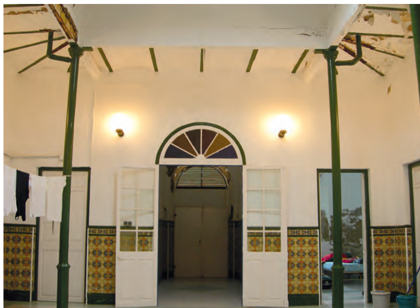
Interior del faro antes de la última restauración. Alrededor de la sala principal se distribuyen todas las habitaciones.
