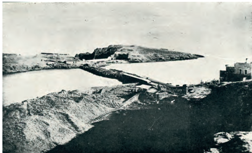
Trabajos de construcción del muelle de unión entre las dos islas entre 1910 y 1911.
