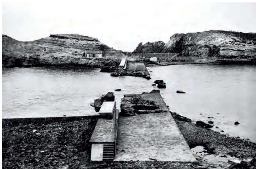
Dique recién destruido por el temporal de 1914 un mes después de terminar su construcción.
