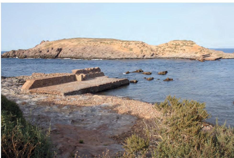
Dique noroeste en la actualidad.
