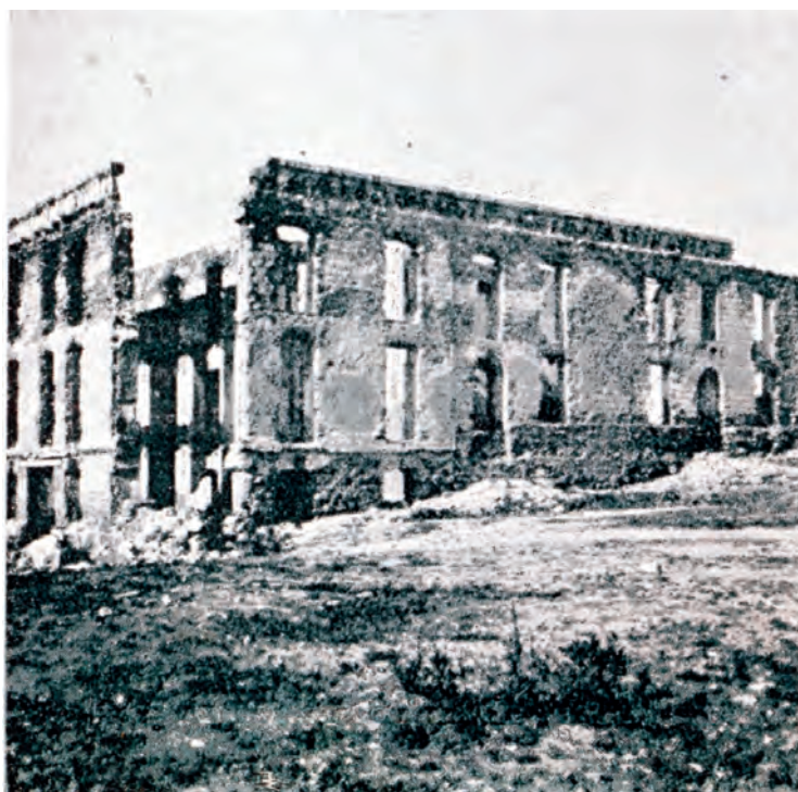
Cuartel de Operarios en ruinas en el año 1947.
