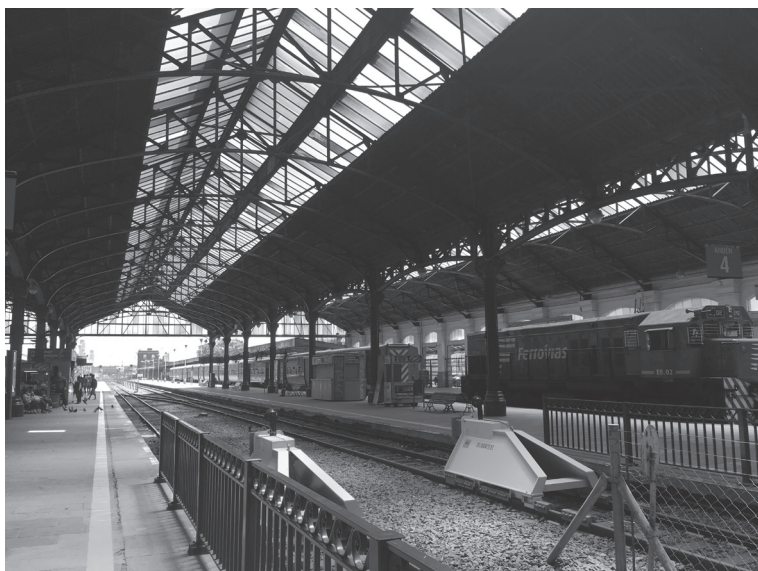
Andenes de la estación de Retiro, Buenos Aires.
