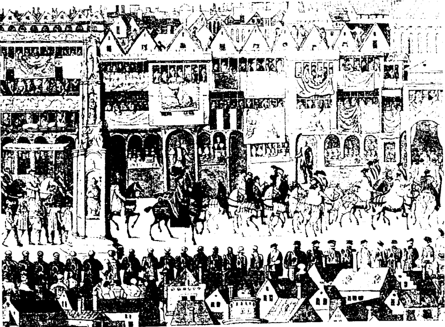
Fig. 14. Tiendas de joyeros en Cheapside, Londres. Pintura de la procesión de la coronación de Eduardo VI, en 1547.
