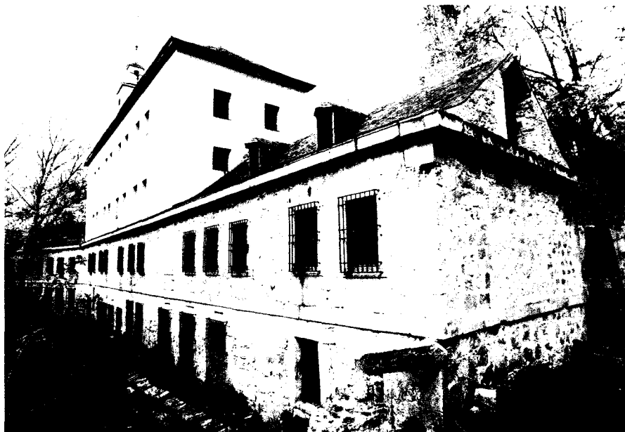
Fig. 6. Estado actual del edificio.
