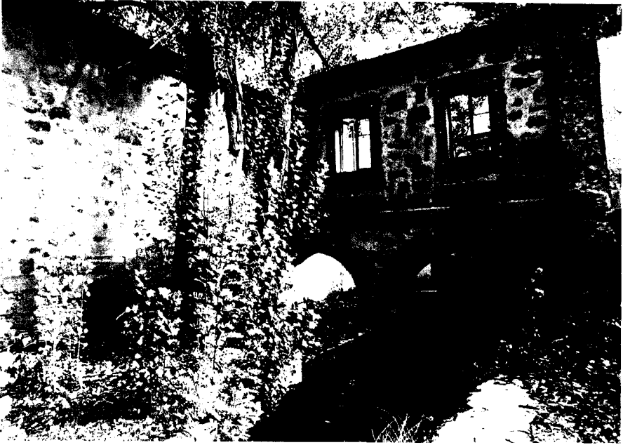
Fig. 1 Estado actual del canal del Real Ingenio de Segovia
