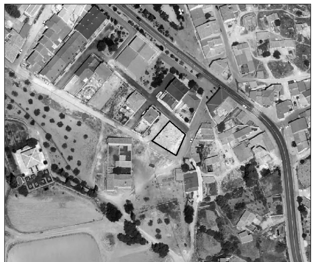
▲ FIGURA 2. Vista aérea de la zona excavada, en el recuadro negro.
