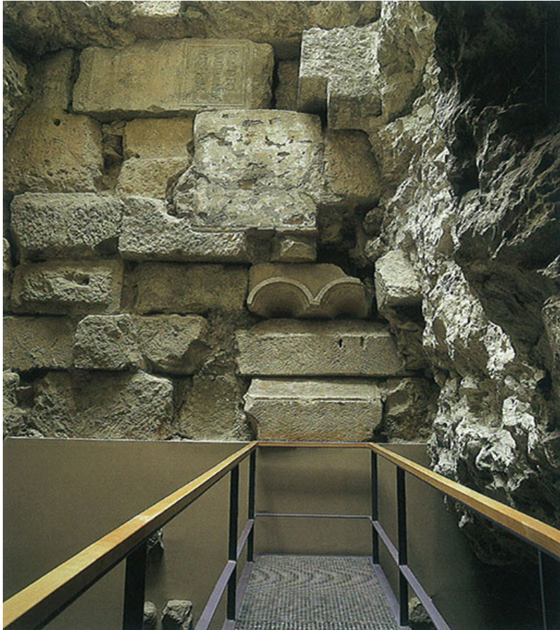
FIG.6.-IMAGEN DEL INTERIOR DE UNA DE LAS TORRES DE LA MURALLA ROMANA DE FINALES DEL S. III D. C. SE OBSERVAN DIFERENTES MATERIALES REAPROVECHADOS, ENTRE ELLOS UN PEDESTAL CON INSCRIPCIÓN (RODÀ 2001: 31)
