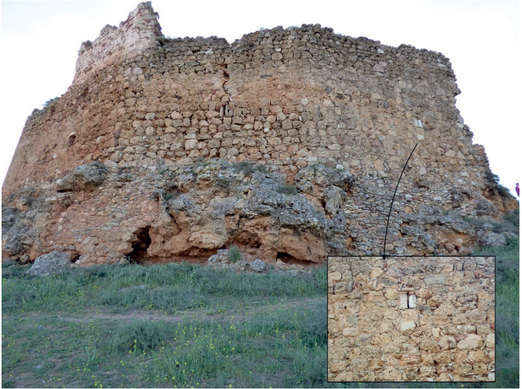
FIG. 9.- VISTA DEL FRENTE OESTE DEL CASTILLO DE ALHAMBRA, CON DETALLE DE SU TÉCNICA CONSTRUCTIVA.
