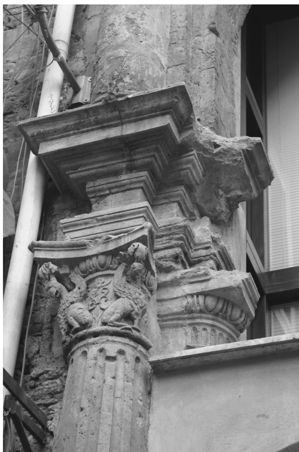
Fig. 6. Palermo. Loggia in via Argentarìa, particolare dei capitelli nel prospetto.
