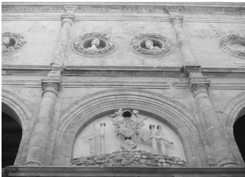
Fig. 8. Palermo. Loggia in via Argentaria, particolare del prospetto.
