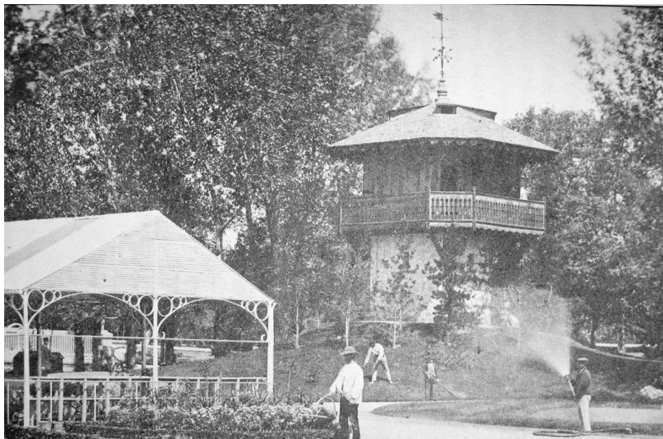
Propiedad de Oñate. Depósito de agua. Hacia 1870 (foto F. Huete).
