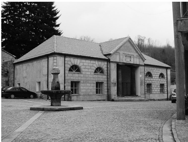
Fig. 10. Real Fabbrica d'Armi dopo il restauro. Copyright: foto eseguita da Francesca Gentile.
