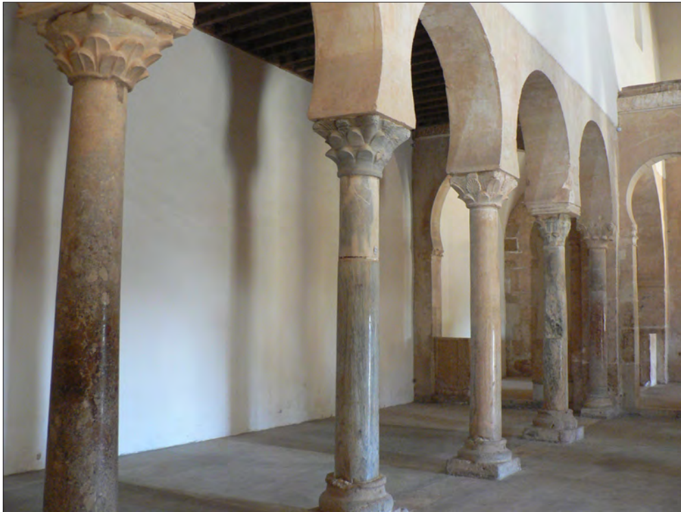
FIGURA 1: SAN MIGUEL DE ESCALADA (LEÓN). SOPORTES MARMÓREOS DE LA NAVE NORTE. SIGLO X. (Foto: Virginia García-Entero)
