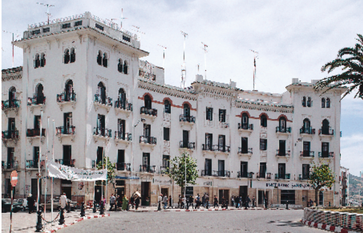
Arquitecto Carlos Óvilo Castelo, edificio para Salomón Benalal (1932), plaza Muley el Mehdi. Fotografía de José Morón, Archivo de la Dirección General de Arquitectura y Vivienda, Consejería de Obras Públicas y Transportes, Junta de Andalucía.
