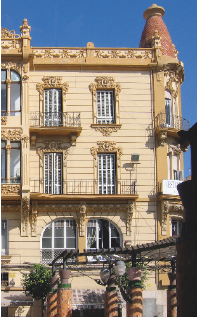
Arquitecto Enrique Nieto Nieto, edificio La Reconquista (1914), plaza Menéndez y Pelayo. Foto A. Bravo, 2005.
