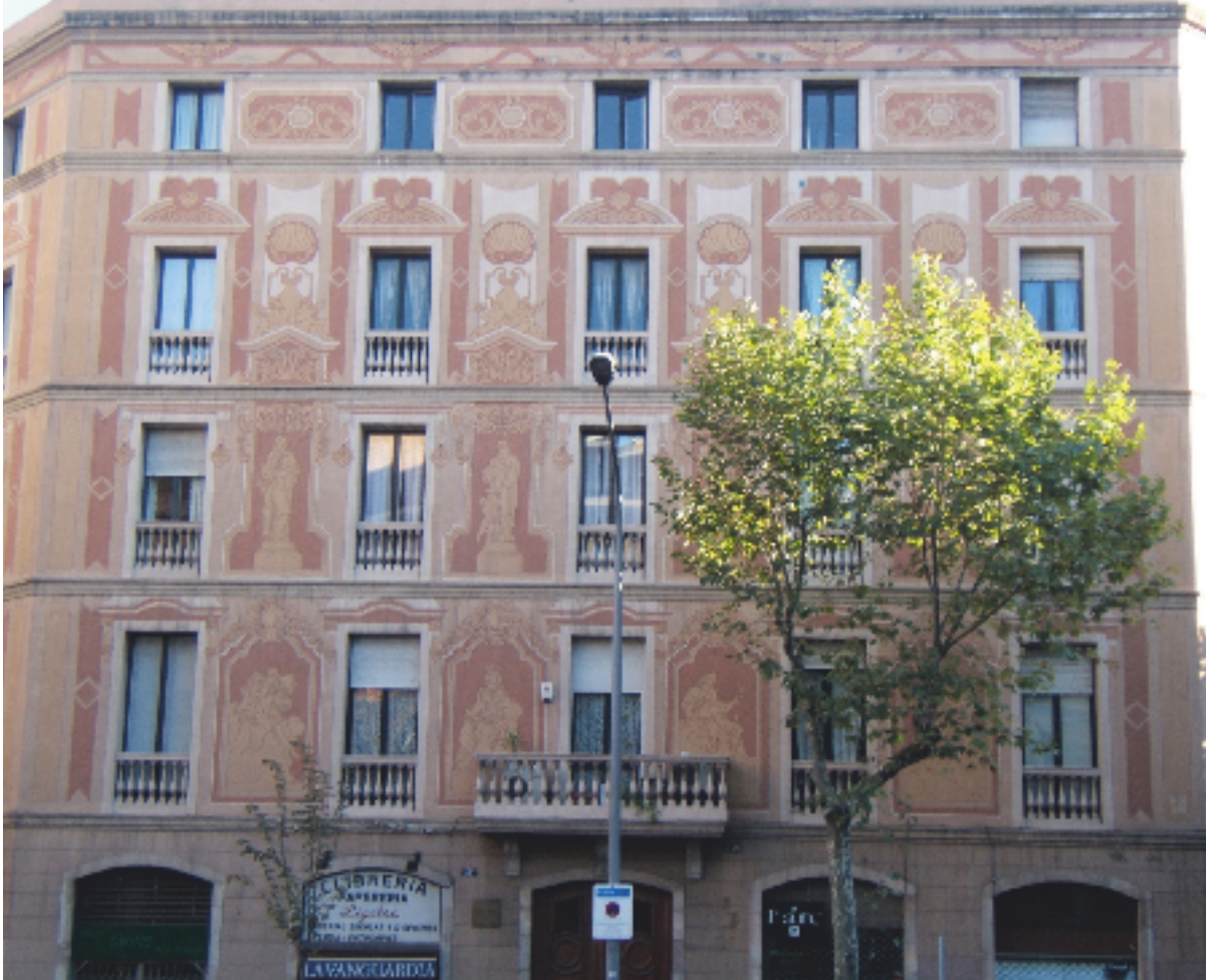
Una de las casas construidas por Josep Cerdà. C/ Consell de Cent, 340, de Barcelona. 1862-1864. Antoni Valls Galí, maestro de obras. Foto: R. Lacuesta, agosto 2005
