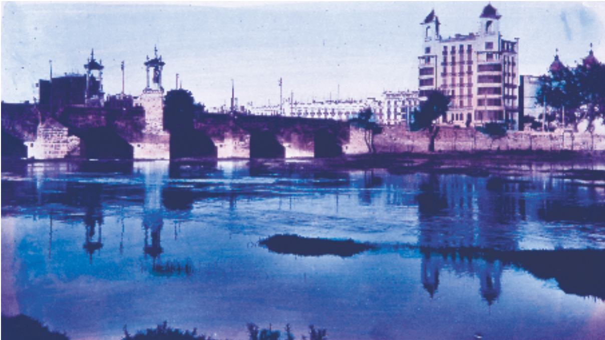
Joaquín Rieta, Edificio Llorente en una postal de época.
