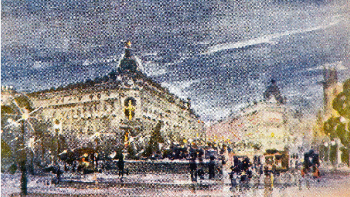
Madrid. A la derecha el edificio "Metrópolis" (1905) en Alcalá 40 y "Grassy" (1916) en Gran Vía 1 y 3, que marcan el comienzo de ésta avenida. Acuarela de L. Ruiz Morales (Revista "La Esfera", 1916)
