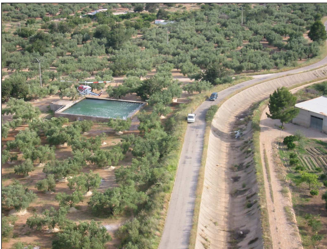
Foto núm. 7. Canal Xerta-Sénia a l'altura del municipi de Tortosa, camí de servei i una bassa utilitzada com a punt de captació d'aigua.
