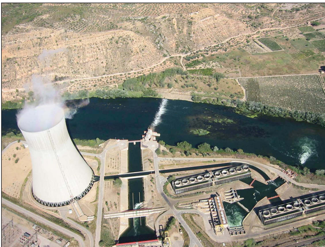
Foto núm. 9. Central termonuclear d'Ascó amb la xemeneia de refrigeració, assut de presa d'aigües i descàrrega al riu Ebre.
