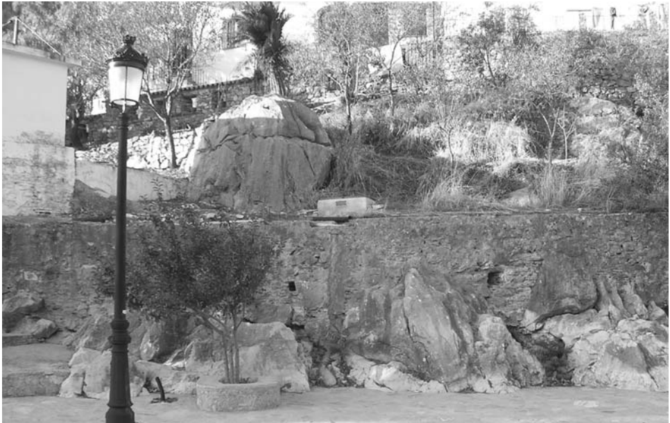
Figura 8. DETALLE DE LA ACEQUIA DEL TRAMO FINAL DEL ACUEDUCTO.
