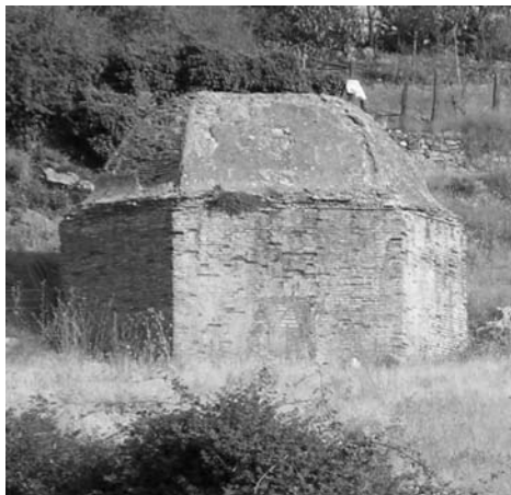
Figura 13. UNO DE LOS POZOS MAYORES DEL QANAT.
