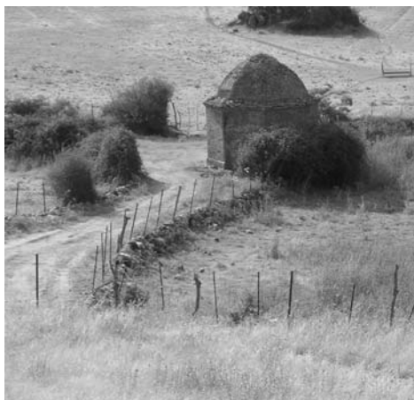
Figura 17. POZO DEL QANAT JUNTO A LA CALZADA ROMANO-MEDIEVAL.
