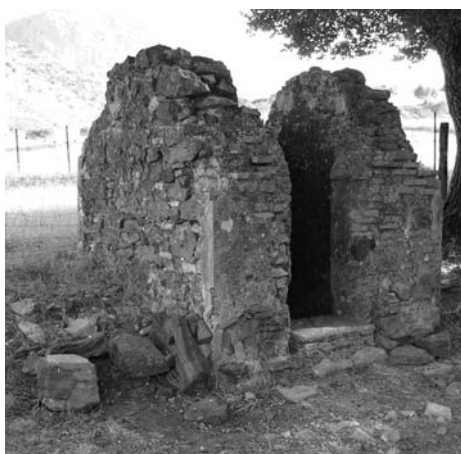
Figura 12. UNO DE LOS POZOS MENORES, QUE HA PERDIDO SU BÓVEDA.
