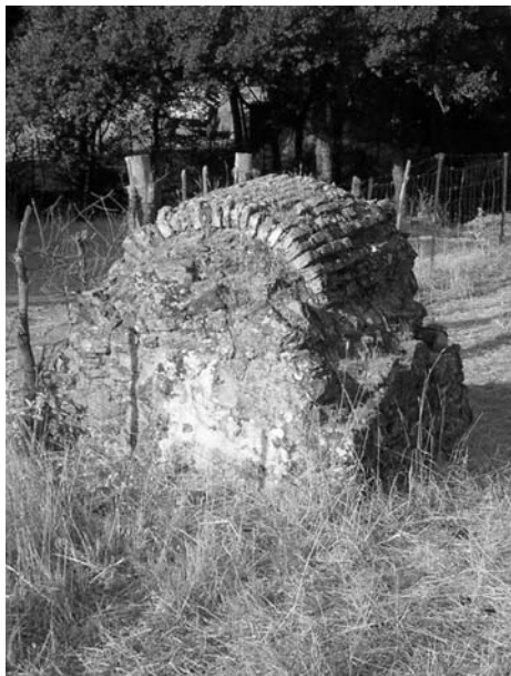
Figura 11. UNO DE LOS REGISTROS O POZOS MENORES DEL QANAT.
