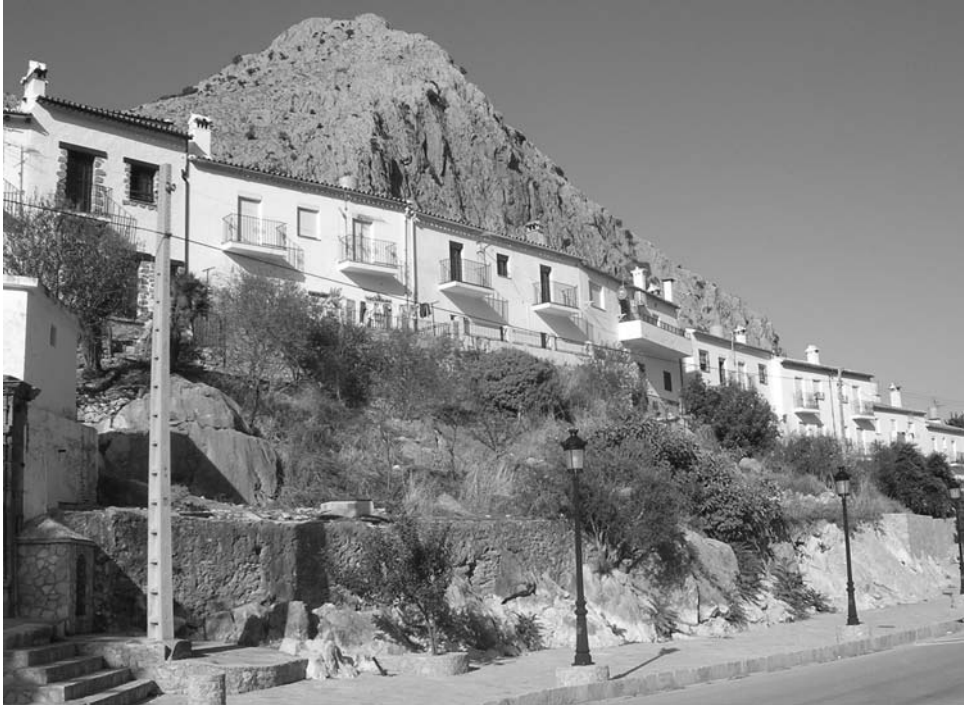
Figura 7. TRAMO FINAL DEL ACUEDUCTO, YA EN EL CASCO URBANO DE VILLALUENGA.
