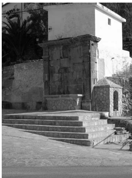
Figura 6. FUENTE TERMINAL DEL ACUEDUCTO.
