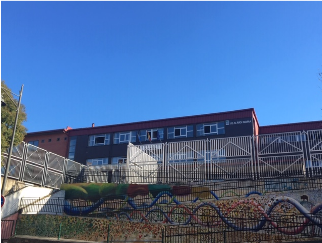
Imagen 15. Fachada principal del IES Río Nora y su acceso por rampa
