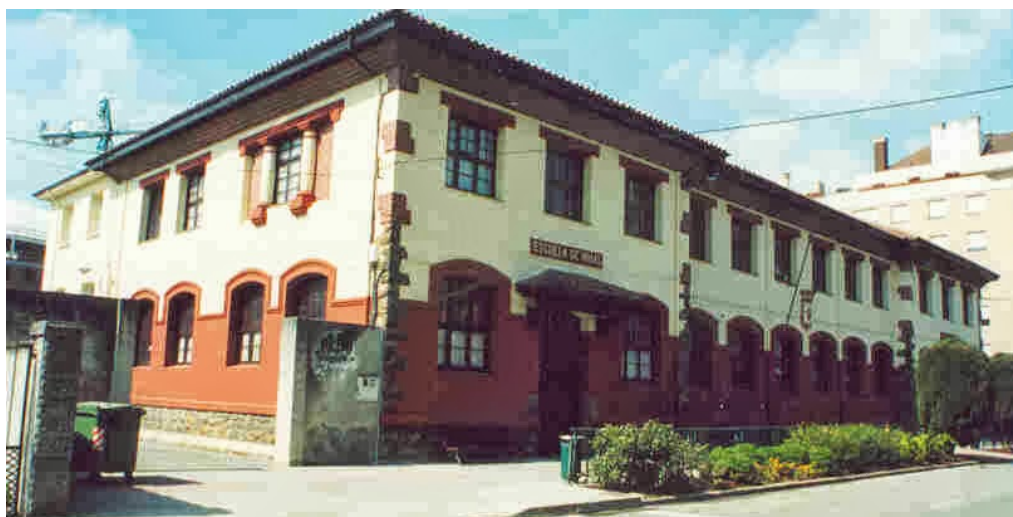
Fachada del Colegio
