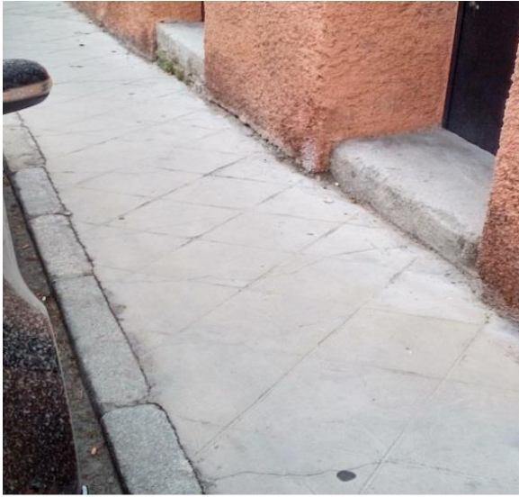
Fig. 16. Acera de cemento situada en Calle de Callejo. Fotografía propia, 2020.
