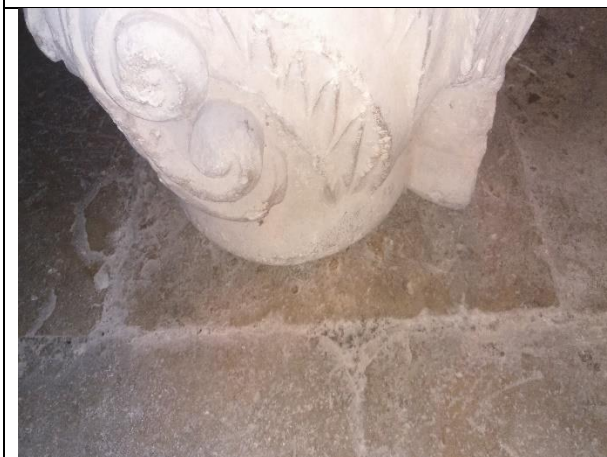
Figura 39. Vista lateral, con el arranque de otra cesta en la parte opuesta y trazos de una talla en el capitel posterior.
