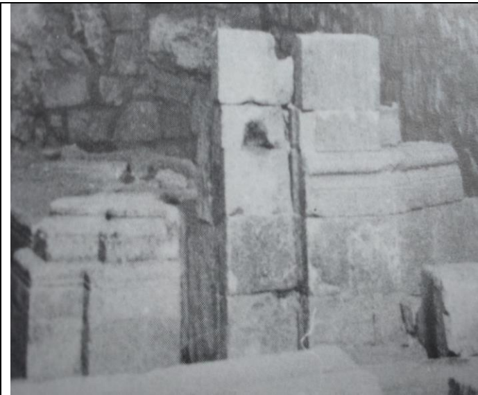
Figura 24. Fotografía de 1964. Machón occidental de la portada interior. Detalle de la moldura de la base.
