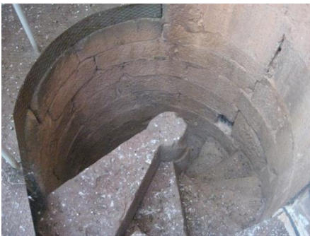
Figura 20. Cuerpo de escaleras en Jaramillo de la Fuente (Burgos). Muy parecido al que aparece en la planta de Silos. Finales siglo XII
