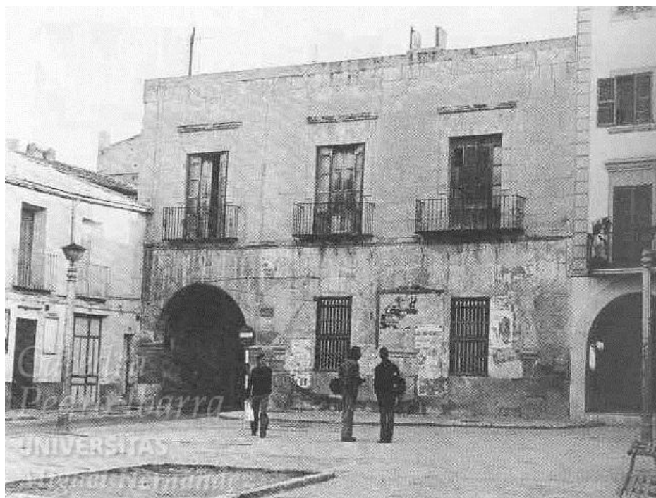
Ilustración 8: Edificio de la antigua Universidad de San Juan en 1975. Fuente: http://www.elche.me/imagen/antic-ajuntament-del-raval-de-sant-joan-1975
