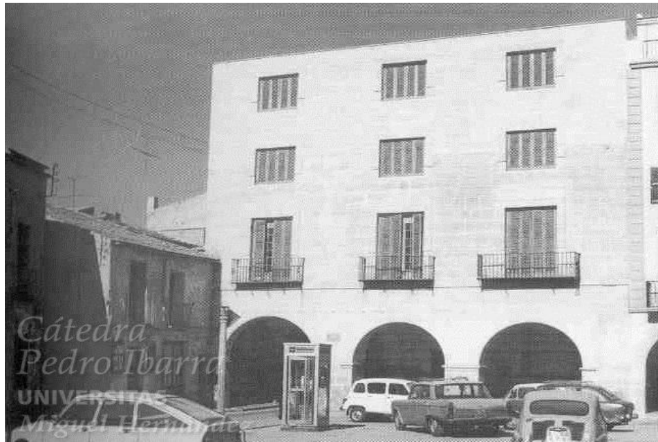
Ilustración 9: Nuevo edificio del gobierno de la antigua Universidad de San Juan en 1978. Fuente:
