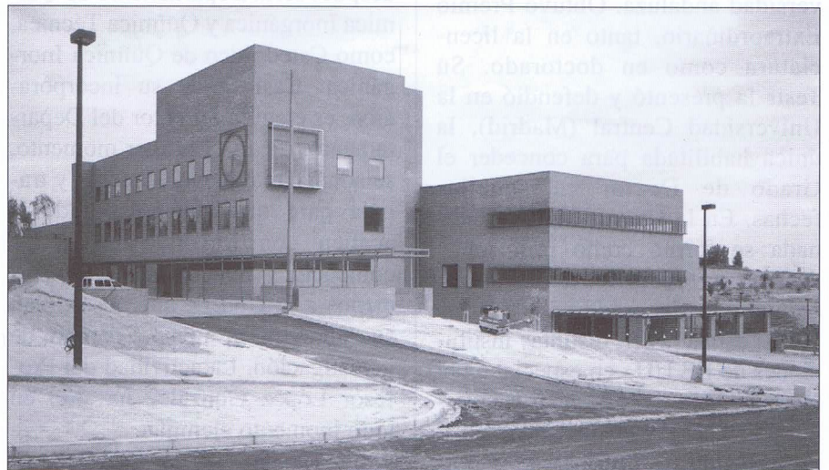
Vista exterior del edificio del Centro Asociado de Madrid-Las Rozas.
