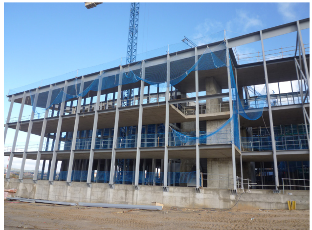
Fotos de las obras del edificio a finales de enero de 2014.
