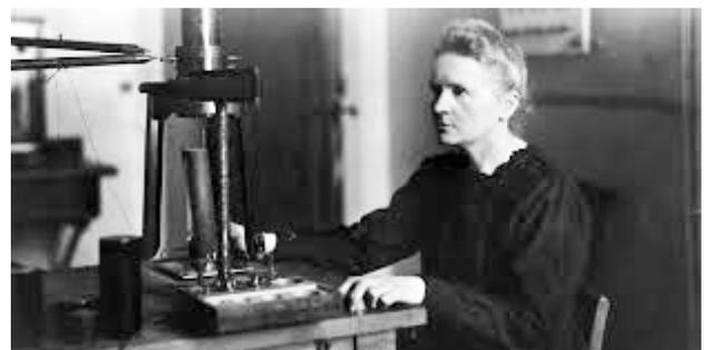
Figura 4. Marie midiendo con el electrómetro piezoeléctrico de cuarzo diseñado por Pierre y su hermano.
