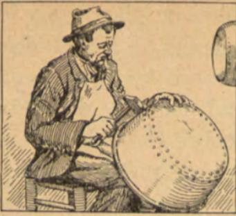
☞ Contemplad a este obrero *calderero* remachando los clavos de un gran *caldero* para juntar el fondo del mismo, con la pared circular de una plancha delgada de cobre que ha remachado antes.
