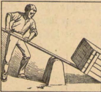
Pasando a las *máquinas simples*, hemos de citar primeramente la *palanca*, la cual no es otra cosa que una barra de *hierro* que permite *mover* grandes pesos, con solo tener un punto de apoyo.
