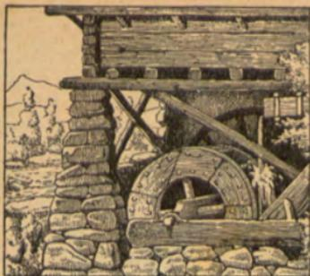
∞ El *molino de agua*, se compone de una *rueda de palos* que gira sobre su eje, cuando cae en las palas el *chorro* de aquélla: el eje tiene un *engranaje* que da movimiento a la *muela*.
