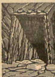
Galerías revestidas para evitar hundimientos.
