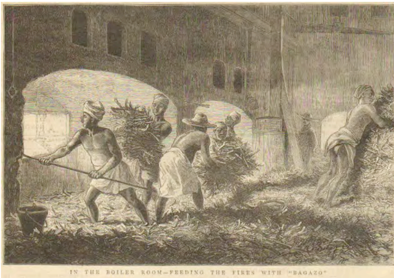
Ilustración 86: Alimentación de las calderas con bagazo (Graphics 1876)
