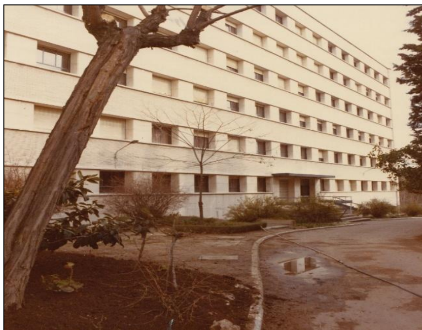
Edificio de reciente construcción que cuenta con seis plantas y amplias ventanas a lo largo de toda la fachada. Fuente: AHE
