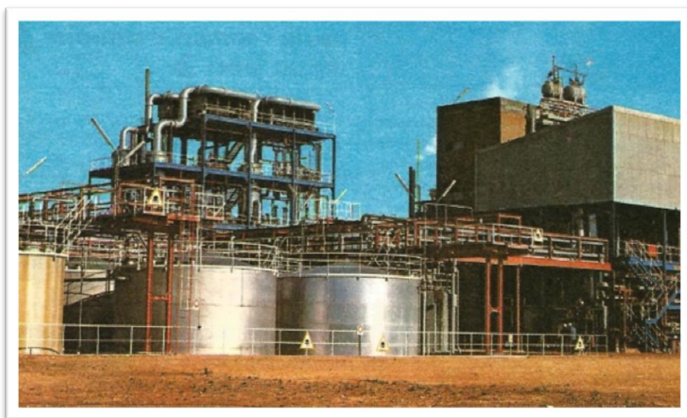
Ilustración 73: “Petroquímica de Tarragona” 124
