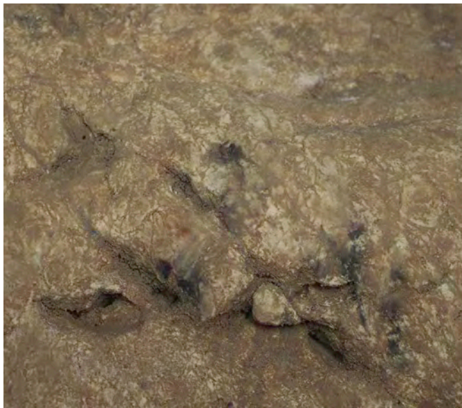
Foto 130. Mancha de color ( 12r ) próxima a los trazos negros. Realce de tonos rojos (B. García).
