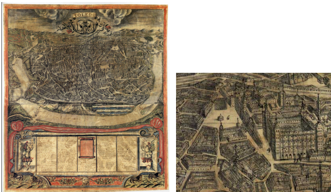
Figura (90) [izquierda]: Panorámica de Toledo de José Arroyo Palomeque, (ca. 1720) y figura (91) [derecha]: detalle de Zocodover
