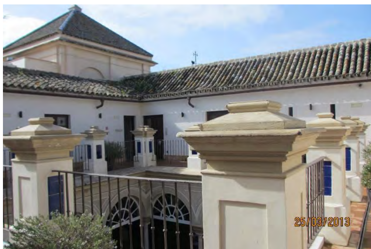
Ilustración 43 Palacio Villapanés, azotea. Fotografía Isabel Corripio
