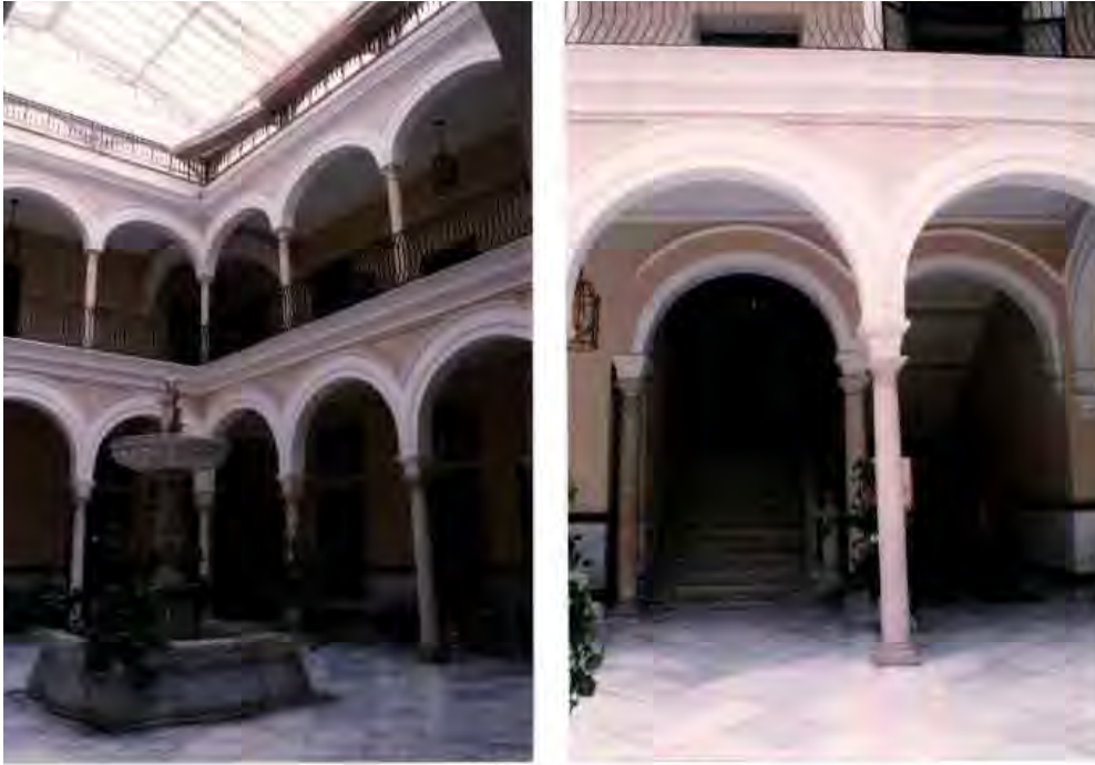
Ilustración 20 Palacio Monsalud, patio y escalera. Catálogo de edificios del plan especial de protección del conjunto histórico de Sevilla. Sector 9. San Lorenzo-San Vicente.
