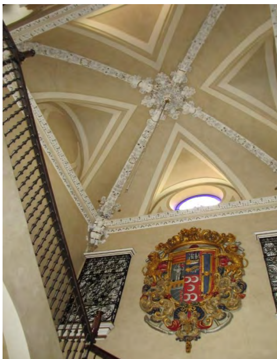
Ilustración 39 Palacio Villapanés, bóveda de la caja de la escalera principal. Fotografía Isabel Corripio.
