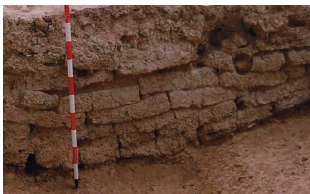
Figura 73. E.F. 11. Anillo perimetral de adobe (Foto Gabinete Trama S. L.).
