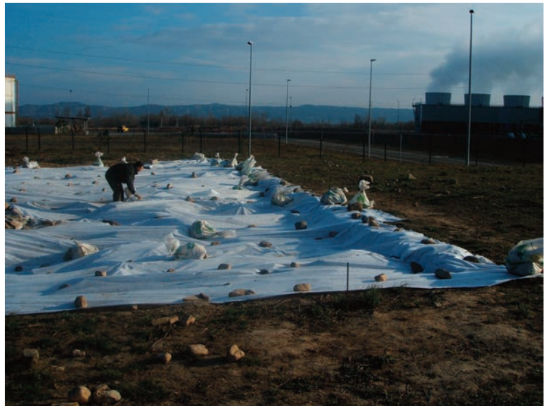
Figura 32. Año 2006. Protección de las estructuras funerarias con lámina geotextil.
