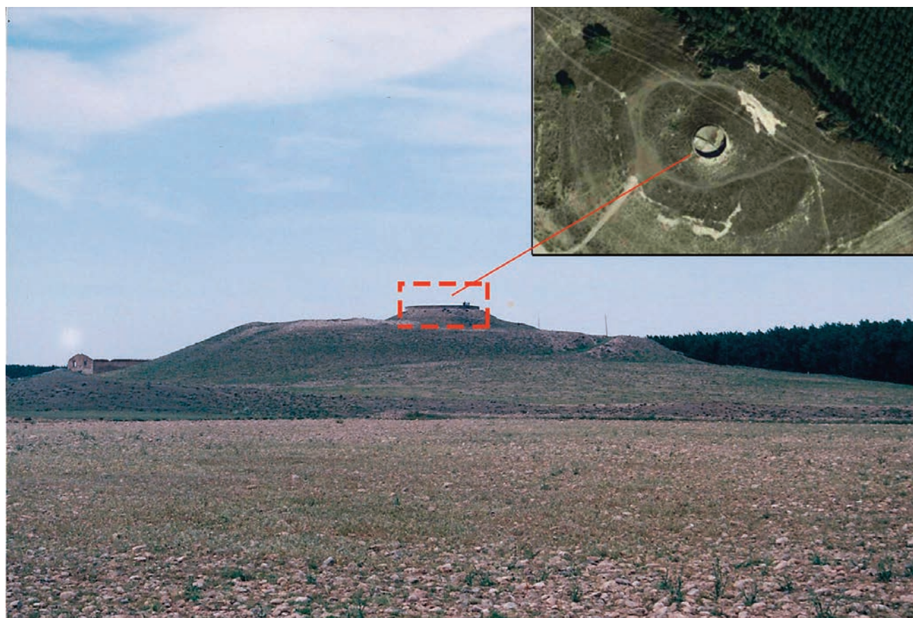
Figura 1004. Depósito de agua de RENFE, ocupando el centro de la plataforma donde se ubica el poblado protohistórico de El Castillo (Foto Gabinete Trama S. L.).
