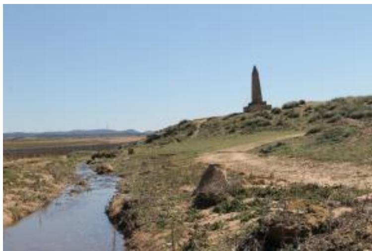
Figura 64 - Vista general del Cerro de los Santos. Fuente: Creative Commons.
