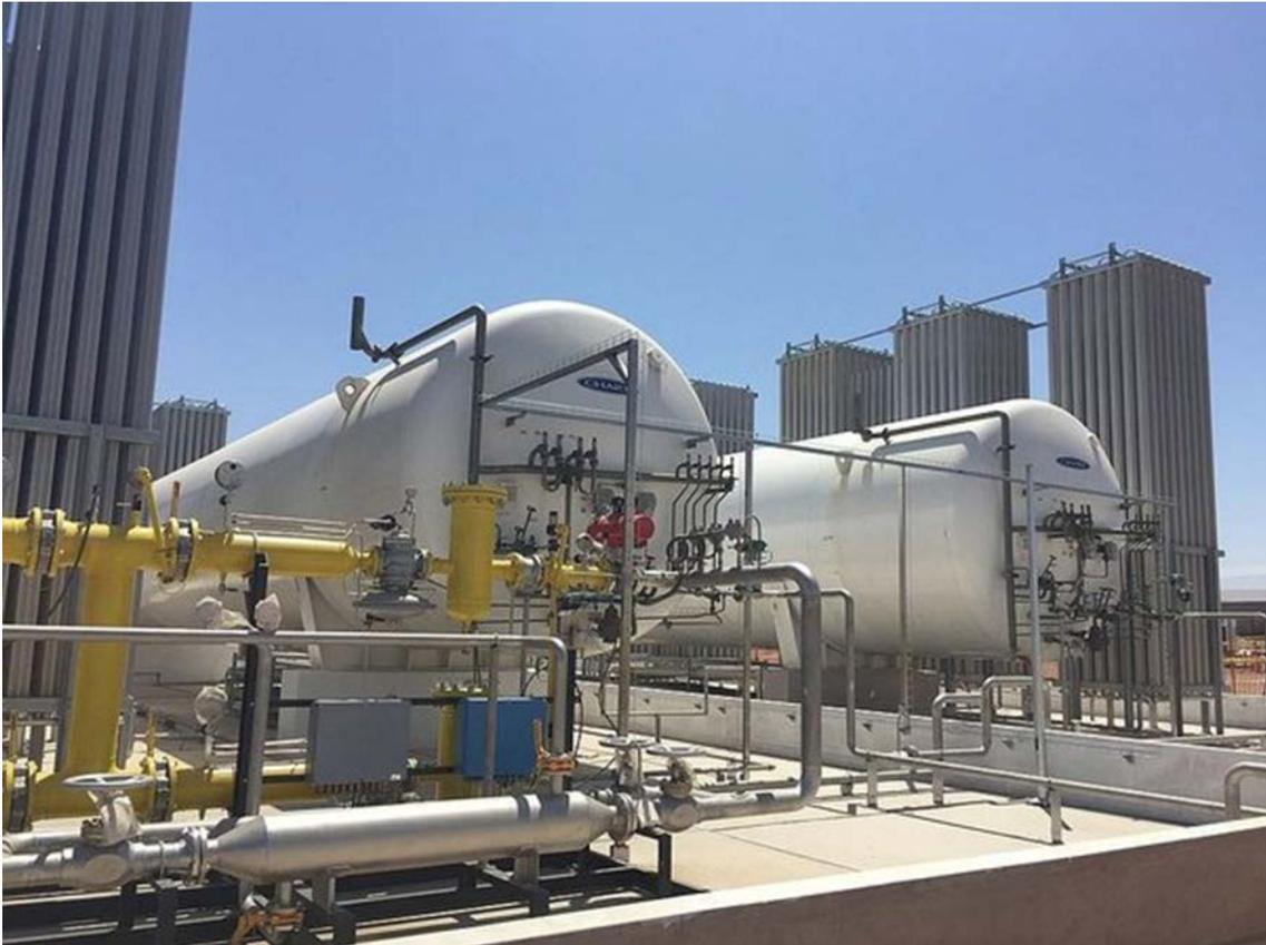
Figura 14. Planta satélite GNL. Depósitos, vaporización y regulación
