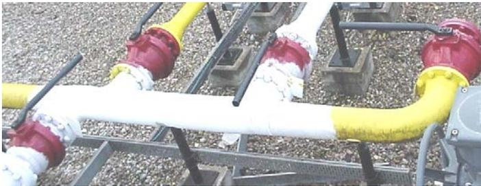
Figura 159. Congelación tubería. Peligro quemadura por contacto (fuente: archivo)
