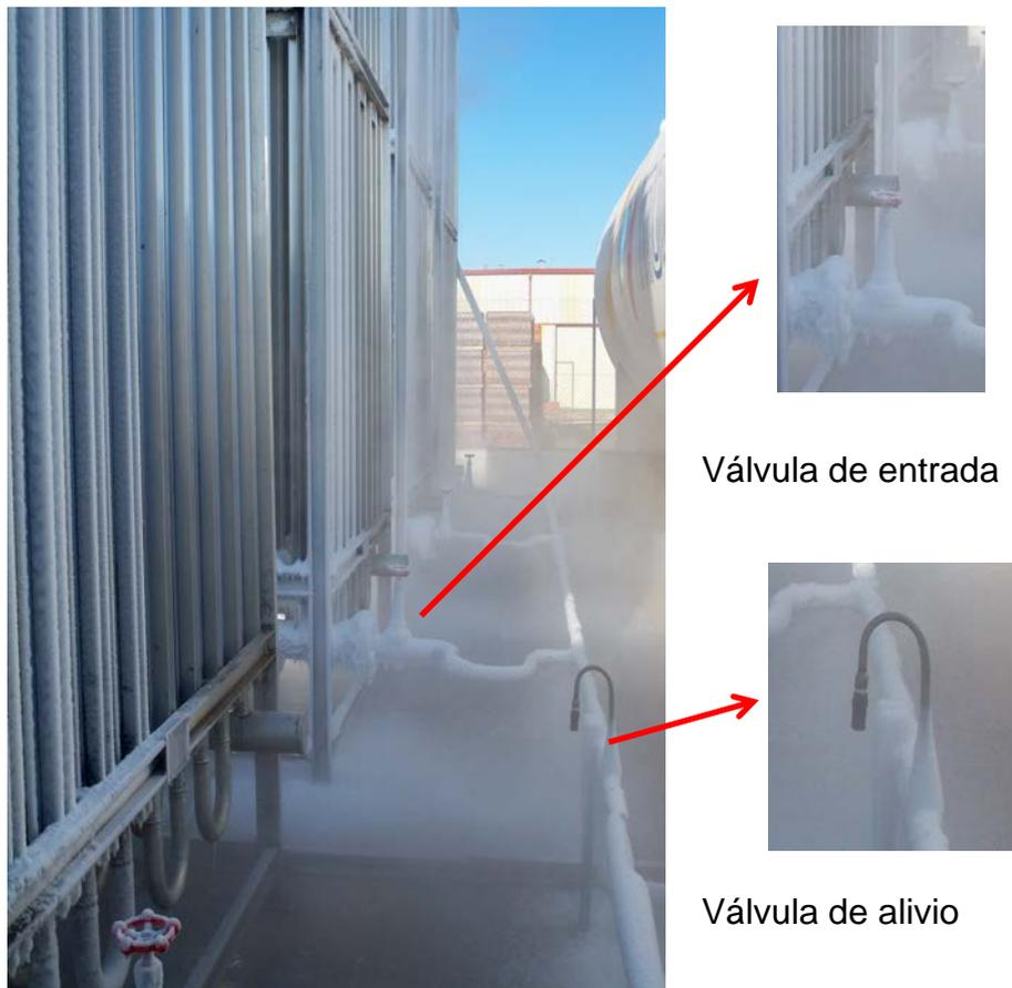
Figura 77. Detalle sistema alivio de presión tubería regasificador
