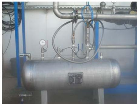
Figura 102. Depósito de odorización
