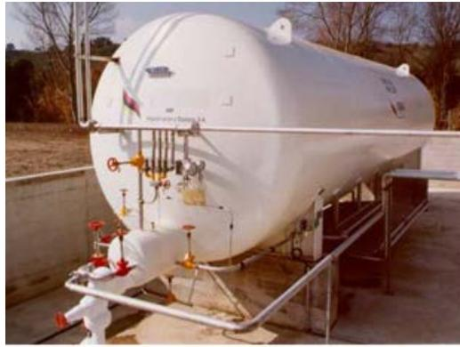
Figura 59. Depósito horizontal
