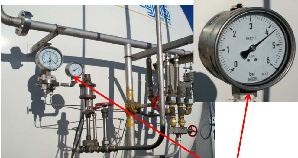
Manómetro de presión de depósito
