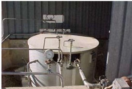
Figura 44. Regasificador con agua caliente
