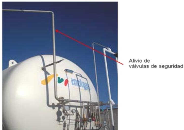
Figura 67. Alivio de válvulas de seguridad
