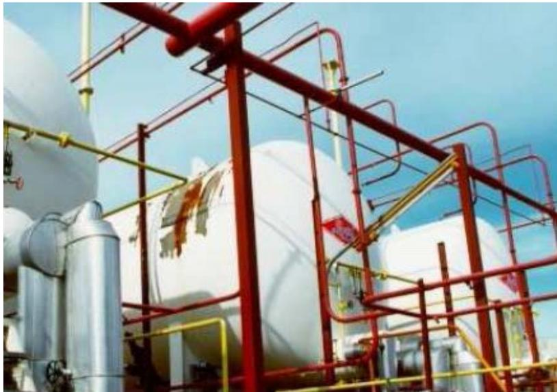
Figura 90. Detalle sistema irrigación
