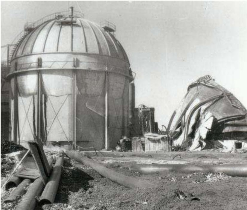
Figura 167. Accidente planta regasificación Cleveland, Ohio (fuente: referencia bibliografía [40])
