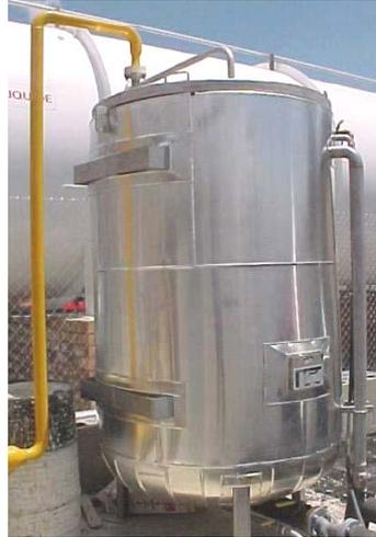
Figura 73. Sistema regasificación de agua caliente en cuba
