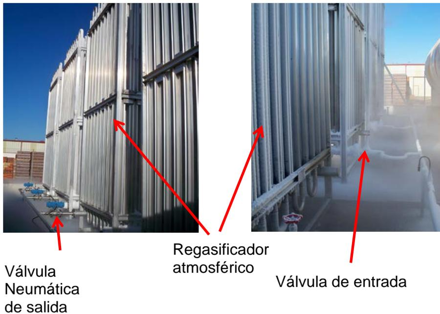
Figura 72. Detalle equipamiento regasificador
