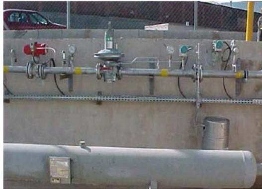
Figura 153. Línea de regulación y odorización
