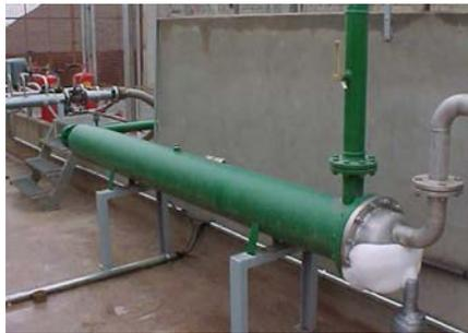
Figura 74. Sistema regasificación de agua caliente por haz tubular
