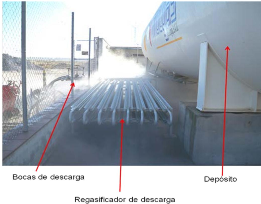
Figura 47. Circuito regasificador descarga
