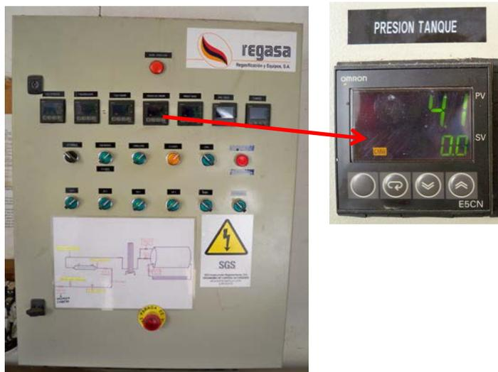
Figura 94. Cuadro de control. Presión depósito
