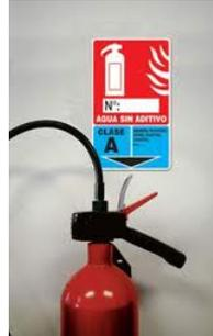
Figura 107. Accesibilidad y señalización extintor
