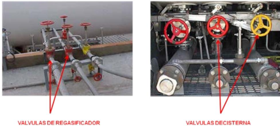
Figura 48. Detalle válvulas circuito descarga
