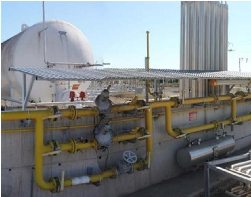
Figura 15. Planta satélite GNL. Detalle ERM
