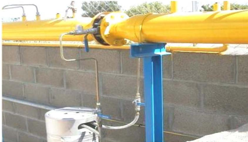
Figura 83. Detalle sistema odorización
