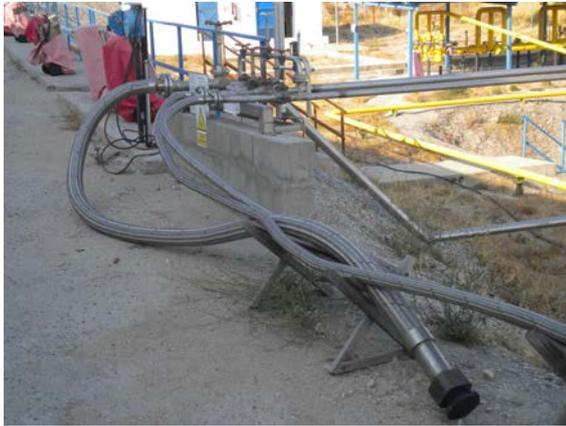
Figura 105. Mangueras de descarga de cisternas
