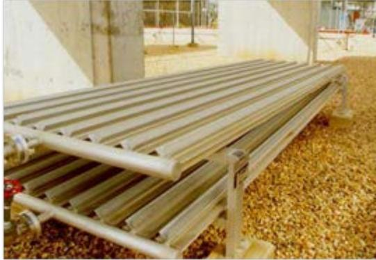
Figura 43. Regasificador de descarga atmosférico
