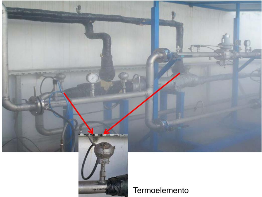
Figura 76. Detalle sistema cierre automático protección sistema (fuente: archivo)
