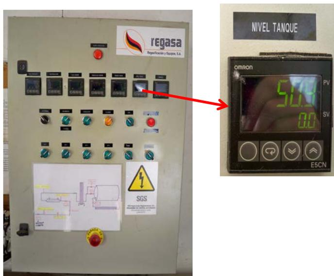
Figura 96. Cuadro de control. Nivel de depósito
