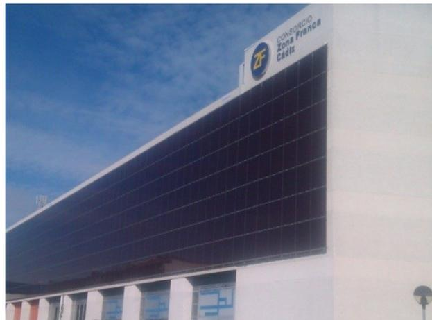
Figura 3.8: Fachada principal de edificio Zona Franca. Los módulos FV de la fachada son de Si-a monocapa.
