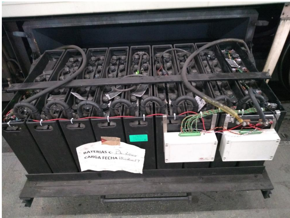
Figura 106: Montaje en el coche 2711.
