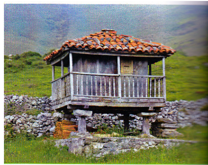
2 Hórreo en el concejo de Yernes y Tameza. Es una construcción aislada y está hecha con piedra y madera.
