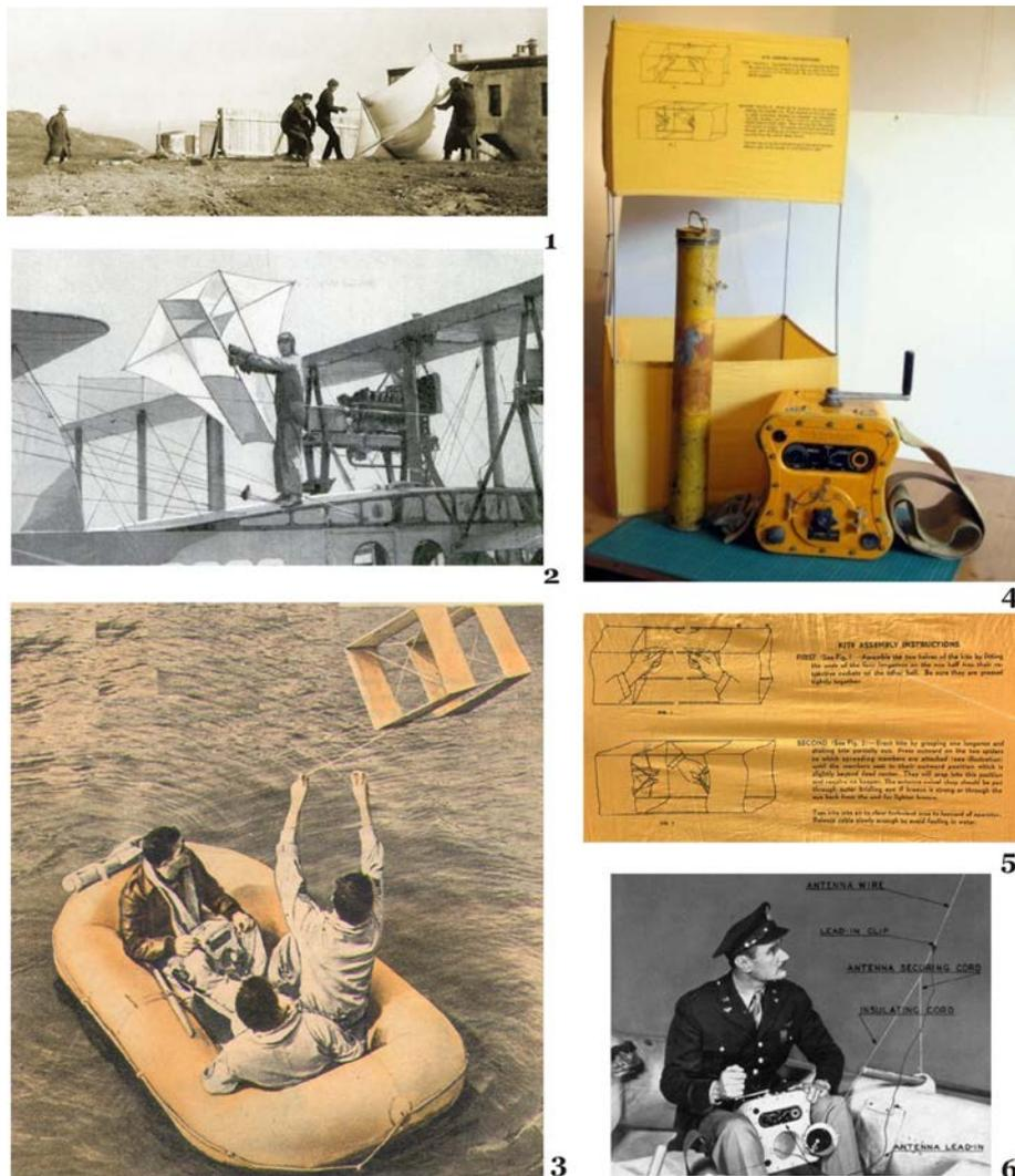
**Fig. 86** Elevación de la antena de Marconi en 1901 (1). Cometa tipo Coyne utilizada como antena en los años veinte del siglo XX (2). Elevación de una *Gibson Girl* (3). Equipamiento completo (4). Instrucciones de montaje de la cometa antena (5). Forma de conectar el emisor (6)
