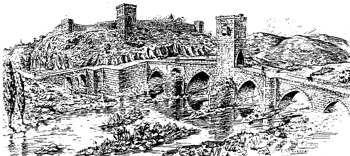
El puente de Guadalajara, sobre el río Henares, tal como debió ser en la Edad Media. Al fondo se ven los muros del arrabal de la Alcallería, y en el centro del lomo, la torre de vigilancia y cobro del pontazgo. (Dibujo de E. GIL GUERRA según apuntes e indicaciones de F. LAYNA SERRANO)
