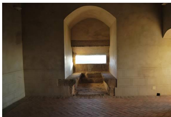
Figura 134: Bóveda de cruceira y balcón con poyo de la torre sur, fotos del autor
