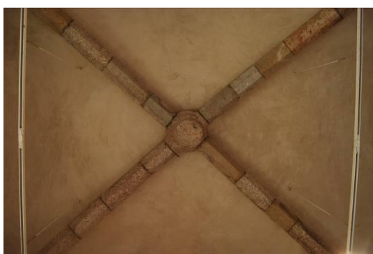
Figura 134: Bóveda de cruceira y balcón con poyo de la torre sur, fotos del autor
