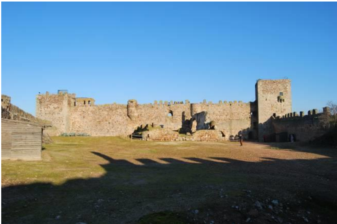
Figura 133: Muro diafragma desde el sector oeste, foto del autor
