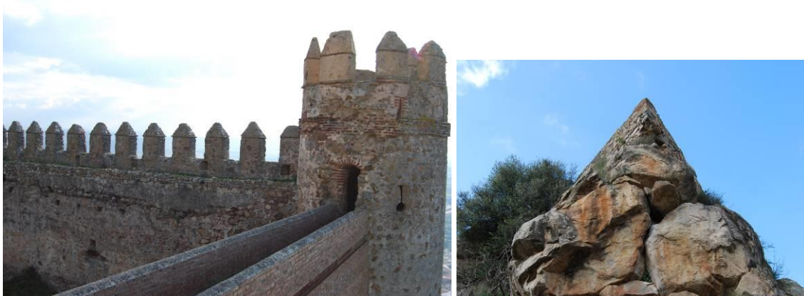
Figura 101: Cubo oeste del castillo y restos del baluarte de planta triangular
