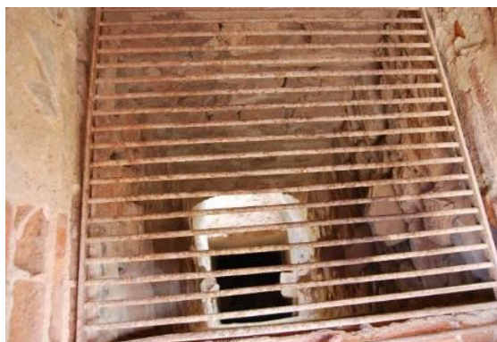
Figura 27: Embocadura de la mina del castillo de Nogales, foto del autor
