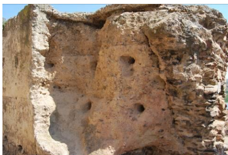
Figuras 64 y 65: Barreras de origen islámico de Villalba y Capilla forradas con camisas externas de mampostería, fotos del autor
