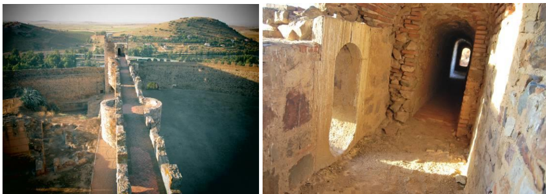
Figura 136: Muro diafragma desde la torre sur, cámara artillera del siglo XV en el muro diafragma con la embocadura del posible corredor excavado en el XVII, fotos del autor
