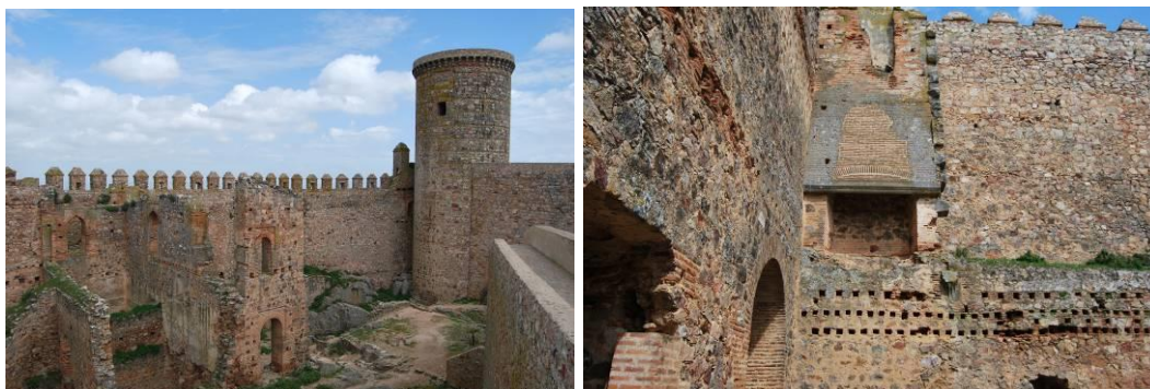
Figuras 152 y 153: Crujía añadida al este del edificio residencial, chimenea y arranque de la arcada que cerraba dicha crujía hacia el este, fotos del autor
