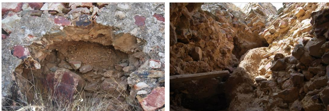
Figura 123: Núcleo de tapia perteneciente a las murallas del castillo islámico, foto del autor
