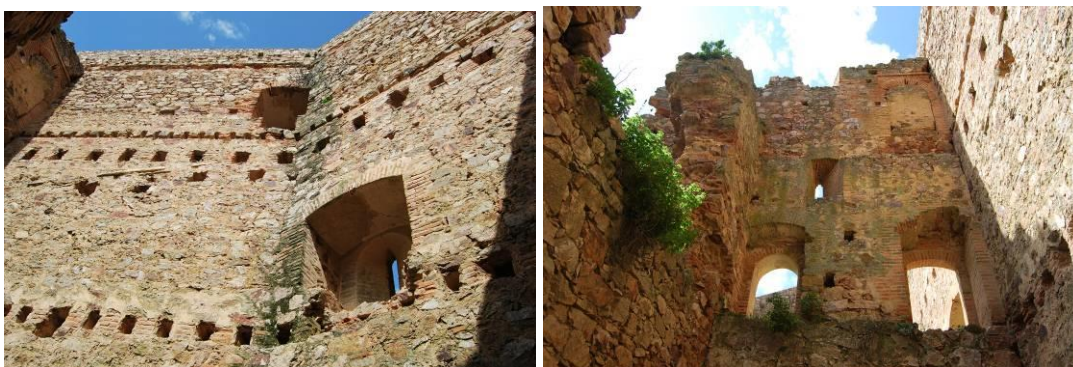
Figura 146: Mechinales de la cubierta original del edificio del sector oeste y crujía central del mismo, fotos del autor
