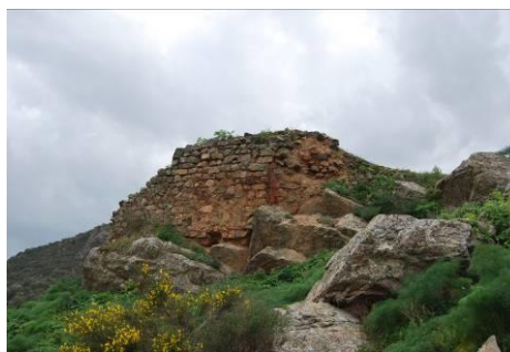
Figuras 64 y 65: Barreras de origen islámico de Villalba y Capilla forradas con camisas externas de mampostería, fotos del autor
