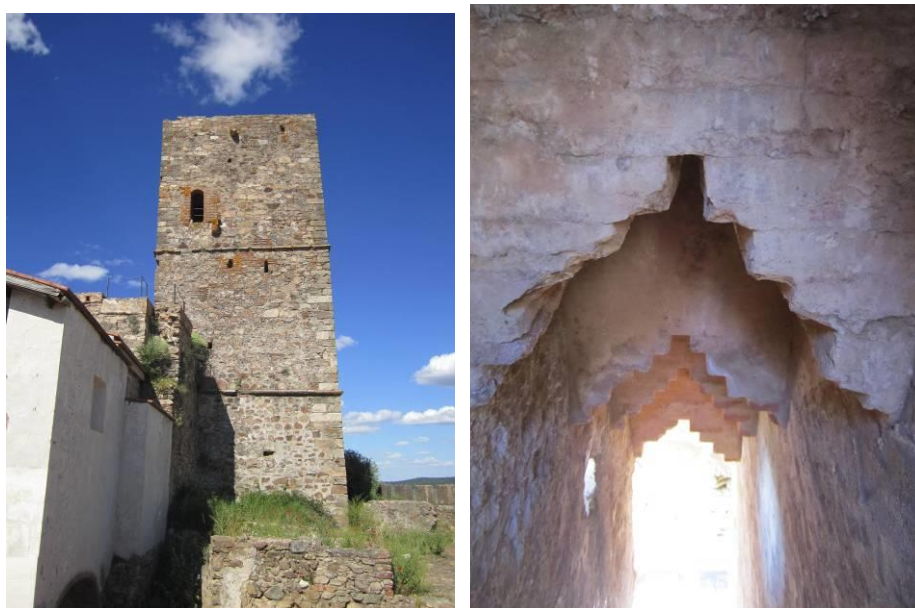
Figuras 158 y 159: Torre del homenaje del castillo de Alconchel y bóvedas de sus escaleras, fotos del autor
