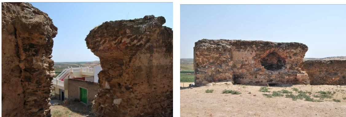
Figura 113: Posibles troneras de la barrera del castillo, fotos del autor
