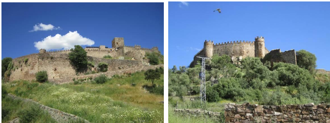
Figuras 162 y 163: Barreras del flanco oriental del castillo y baluarte de planta triangular, fotos autor
