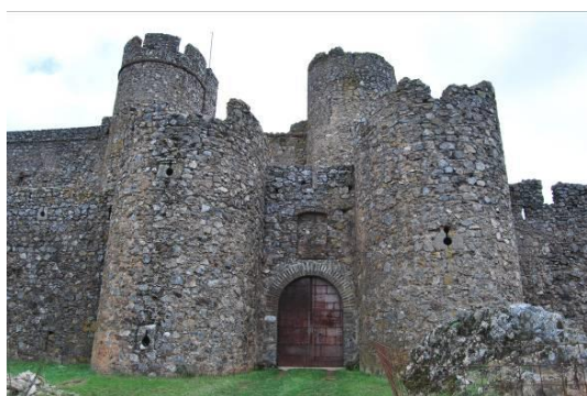
Figuras 54 y 55: Cubos artilleros de sección en D del castillo de Salvatierra de los Barros y único cubo conservado del castillo de Torre de Miguel Sexmero, fotos del autor
