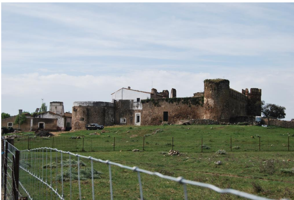
Figura 167: Vista general del castillo de Los Arcos, foto del autor.
