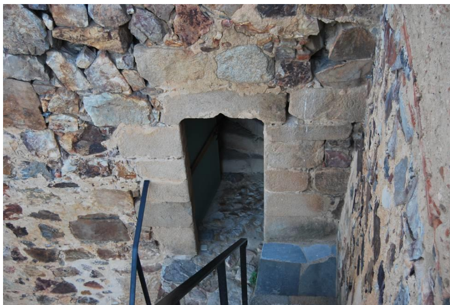
Figura 137: Acceso a la caja de escaleras embutidas en el muro diafragma desde el sector este, foto autor
