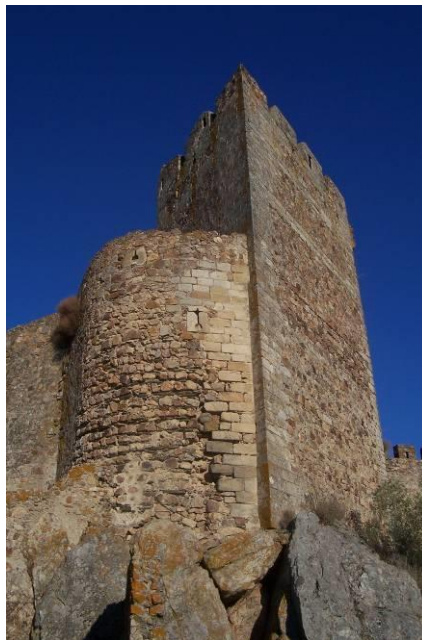
Figura 92: Cuerpo adosado a la torre pentagonal dotado de troneras, foto del autor.
