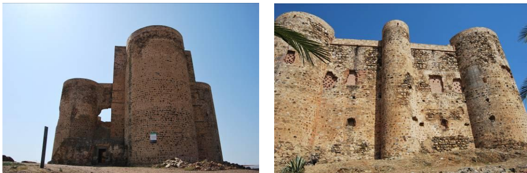
Figura 110: Cortinas noroeste y sureste del castillo de Villalba, fotos del autor
