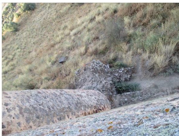
Figura 127: Restos de la muralla romana en la base de la cortina norte del castillo, foro del autor
