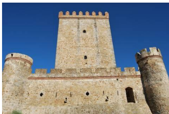
Figura 22: Poterna y base ataluzada del castillo de Nogales, foto del autor
