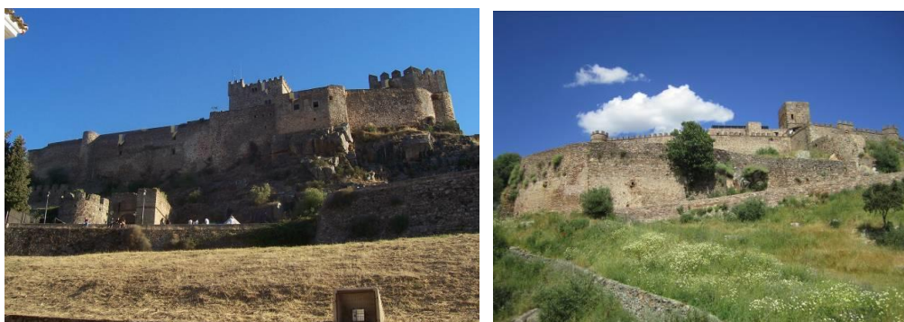
Figuras 71 y 72: Flanco norte del castillo de Albuquerque y conjunto de barreras del castillo de Alconchel, fotos del autor
