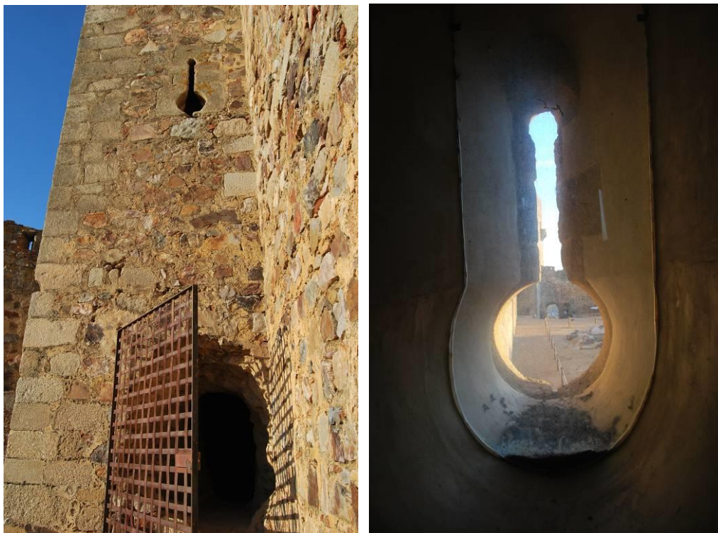
Figura 138: Torre norte del castillo, abertura del aljibe-prisión y tronera que enfila la puerta sur, fotos del autor
