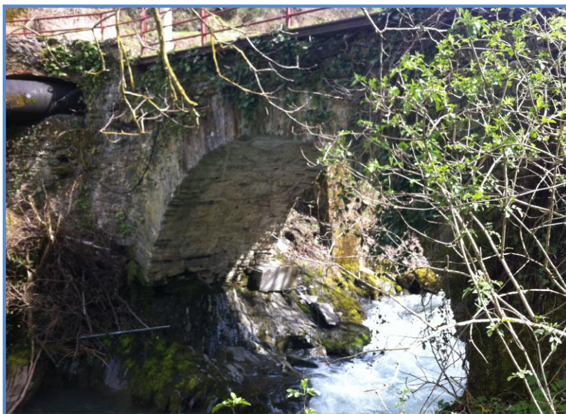
Fig. 213. Puente en La Paraya sobre el río Aller
