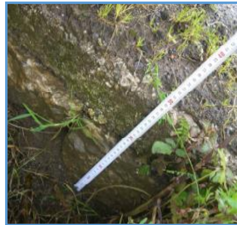
Fig. 20. Perfil visible con la parte superior de 20 cm. de cemento y asfalto.
