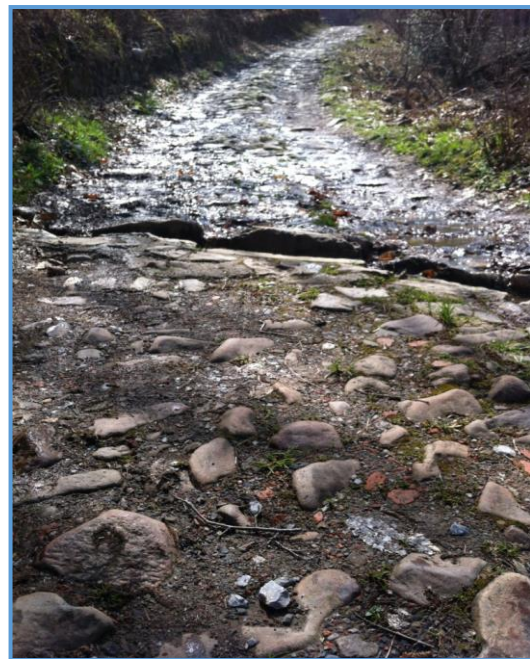
Fig. 202. Detalle de la calzada con la sangradera, cerca del Molín de Peón, del Puerto de Vegarada.
