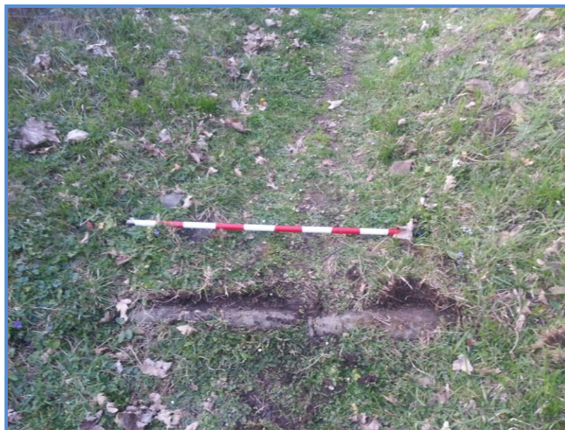
Fig. 189. C. Detalle de losas transversales alargadas, documentadas en el tramo más cercano a la AS-253.
