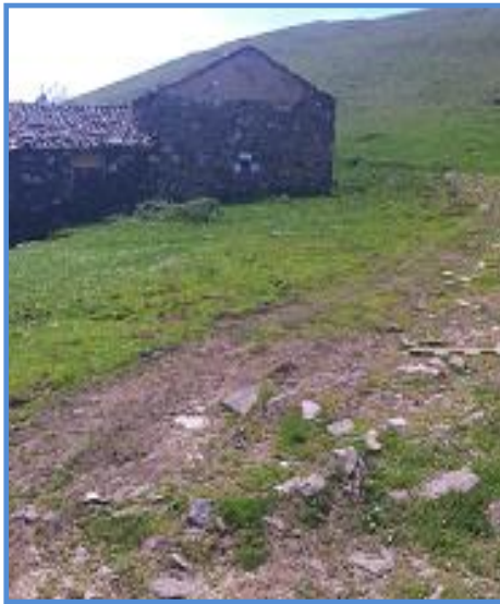
Fig. 110. Paso de la vía por la Venta de Porcabezas
