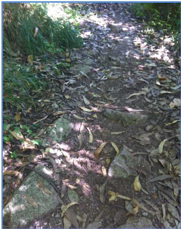
Fig. 170. Detalle de los restos del lateral del camino en Portazgo.
