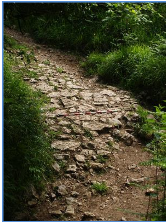
Fig. 146. Sector acondicionado con aspecto más moderno con cantería trabajada y regular en Andriás
