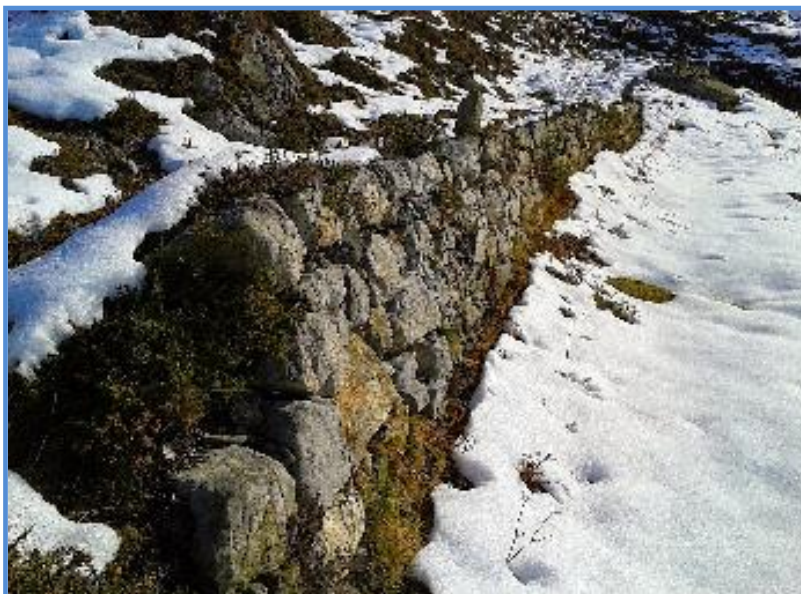
Fig. 249. Contrafuertes de la vía a su paso por La Bobia
