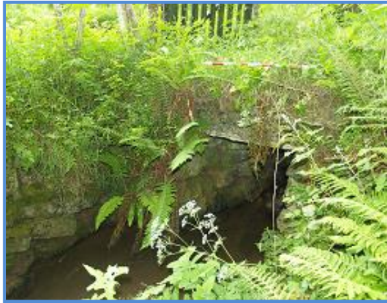
Fig. 154. Puente próximo a Pedroveya.
