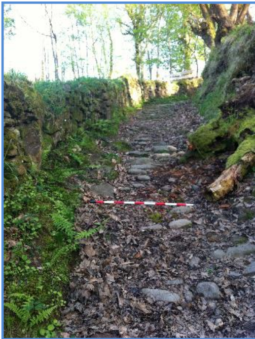
Fig. 238. Sector enlosado y muro lateral entre KM 5-6 de Sm-2
