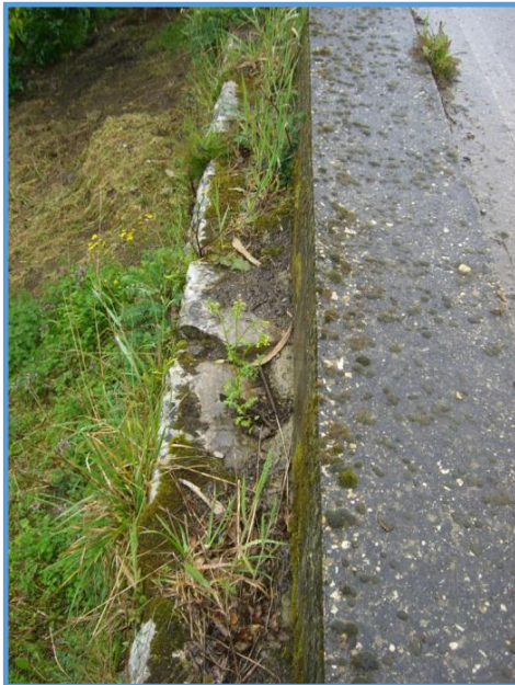
Fig. 19. Lateral del enlosado visible bajo la actual carretera asfaltada AS-232.
