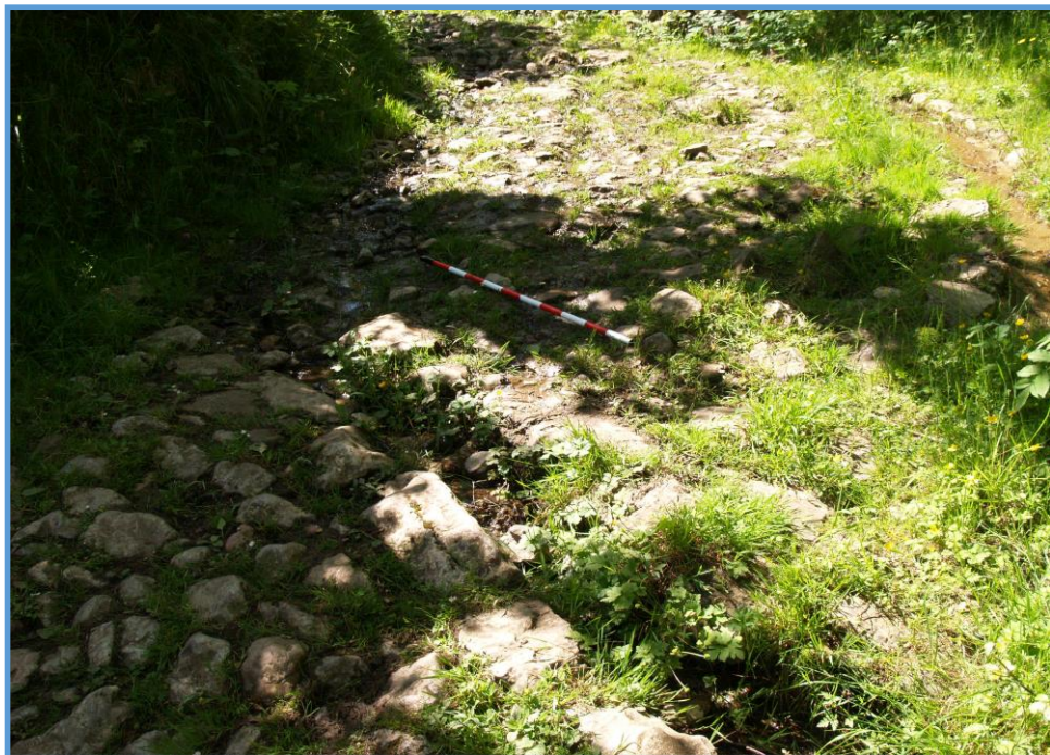
Fig. 148. Sangradera o sistema de desagüe de la calzada. La Rebollada
