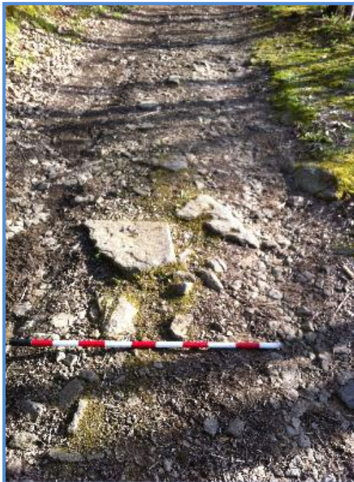
Fig. 241. Restos de empedrado en el camino hacia La Bobia a los márgenes la acera oculta
