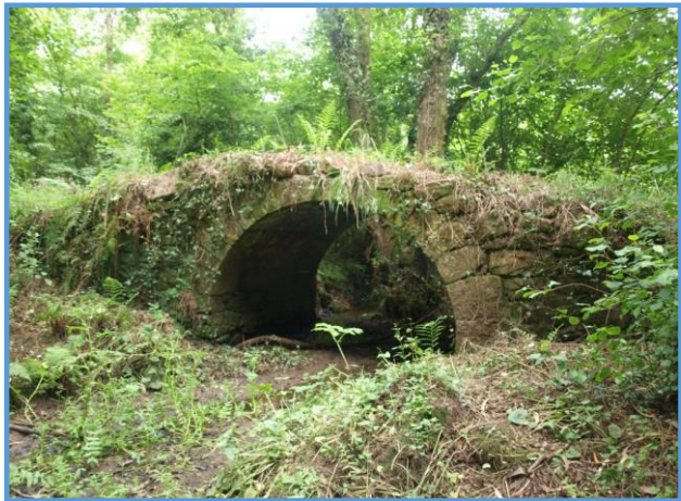
Fig. 347. Antiguo puente de la Llomba, Lue. Ramal hacia Lastres.
