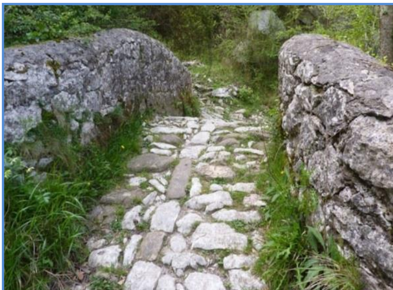
Fig. 288. Calzada del puente de Pompedro
