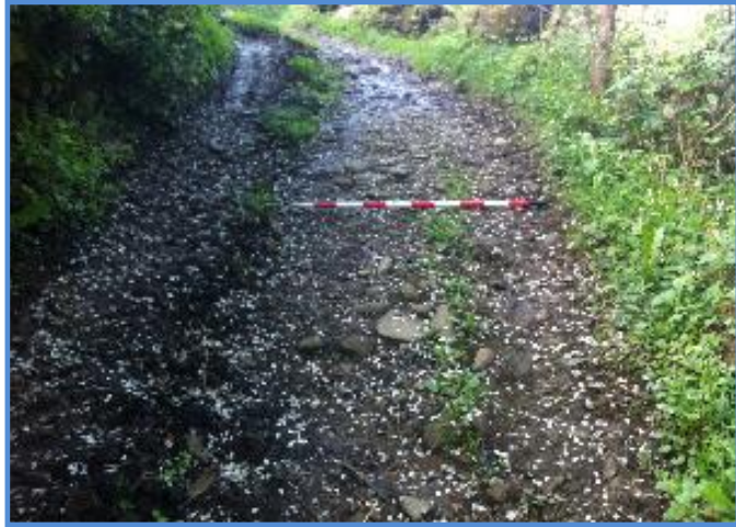
Fig. 256. Vista de la vía cerca de La Espesura
