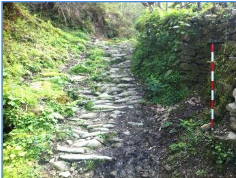
Fig. 237. Aspecto de la vía en el paso de El Reguero
