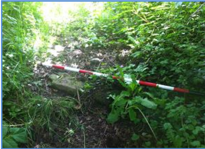
Fig. 121. Sangradera o desagüe de la vía de Lodos a la Cabaña en las proximidades de la carretera GR- 101
