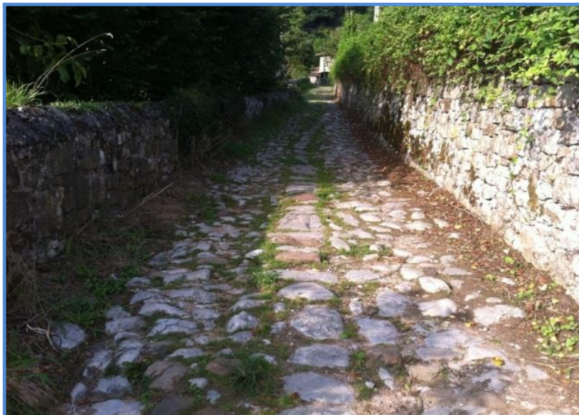
Fig. 268. Enlosado en Benia de Onís.
