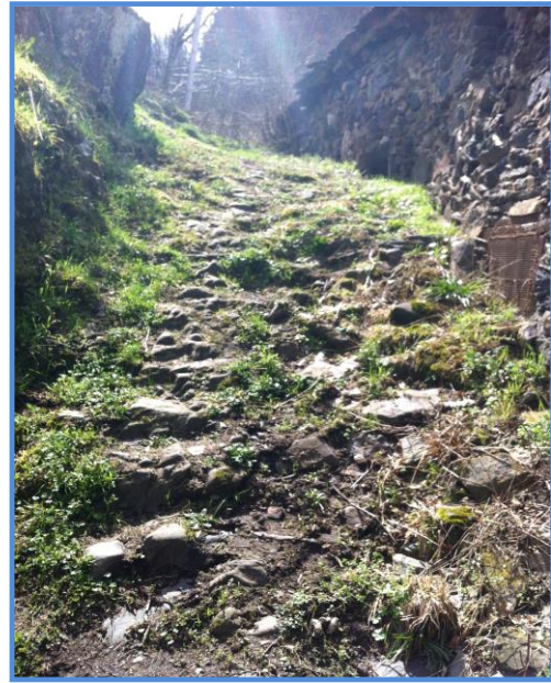
Fig. 214. Restos de calzada en el pueblo de La Paraya, próximo al puente.
