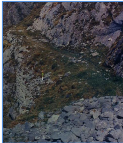
Fig. 181. Muro de contención del sector de Largarelo
