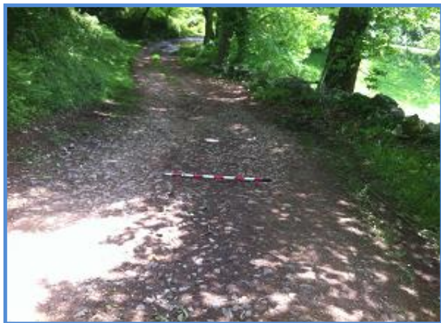
Fig. 118. Vista de la calzada enlosada en la zona de La Cruz
