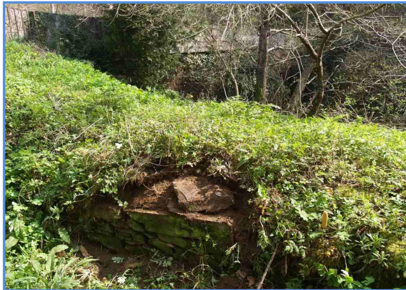
Fig. 70. Vista del calzo Oeste de la antigua vía en Las Mestas
