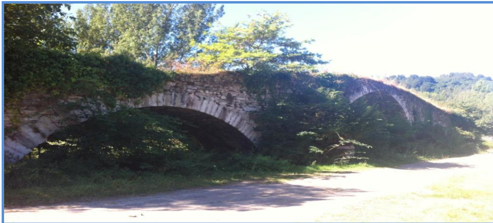
Fig. 169. Vista actual del puente de Olloniego
