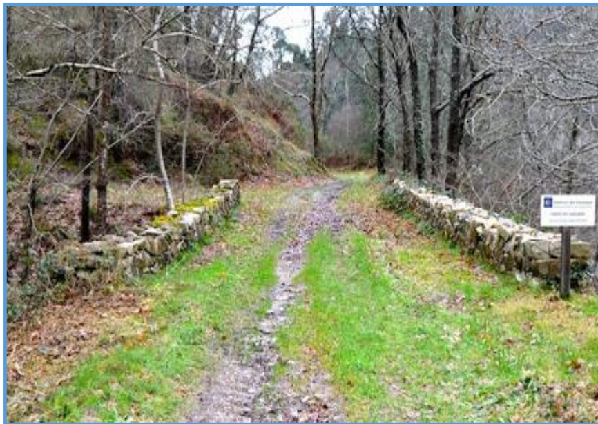
Fig. 25. Paso de la calzada sobre el Puente de Carcabón
