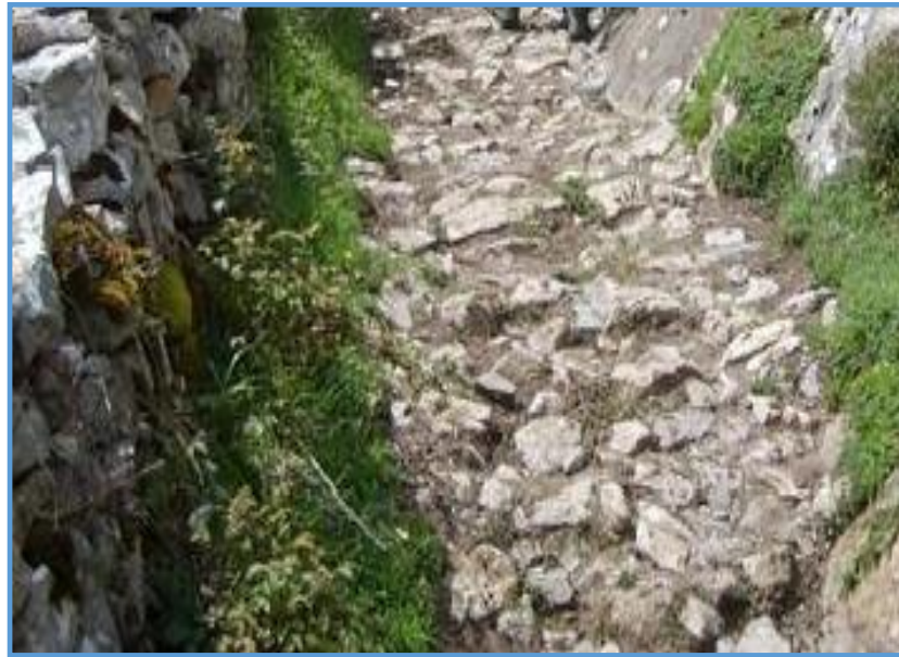
Fig. 82. Calzada a su paso cerca de Las Veigas
