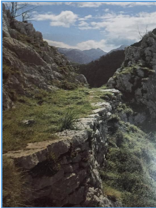
Fig. 223. Detalle de los muros de mampostería en El Negru de Tarna. Imagen extraída de Mañana Vázquez, 1997: 230.
