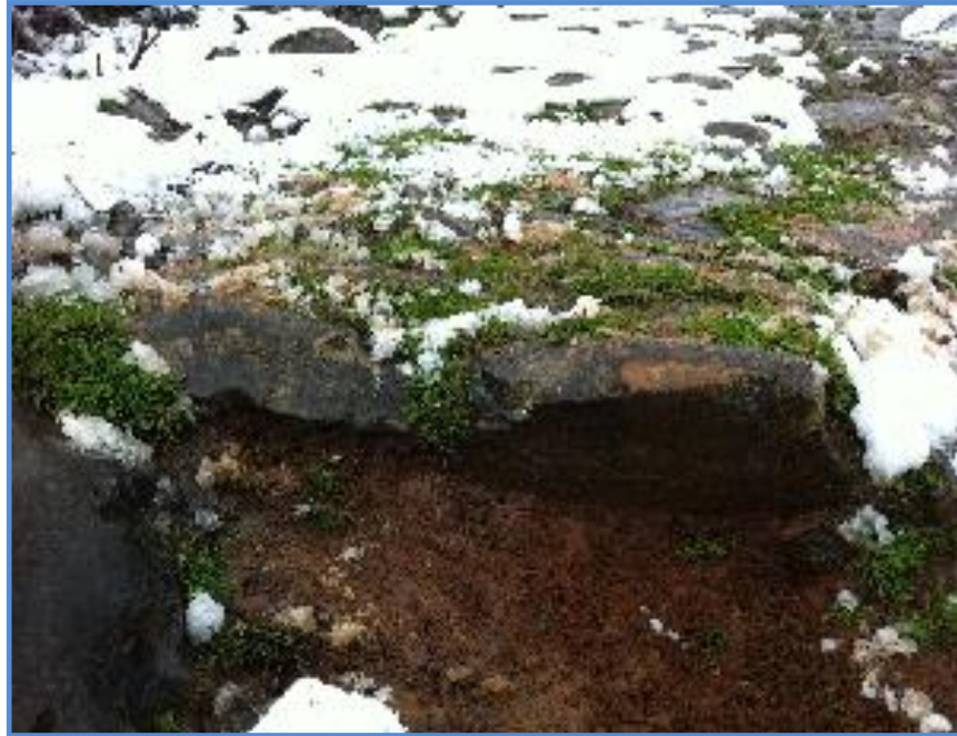
Fig. 235. Detalle visible de la estructura de la calzada de Rioseco
