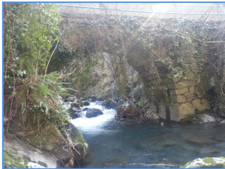
Fig.206. Puente de piedra en Río-Aller
