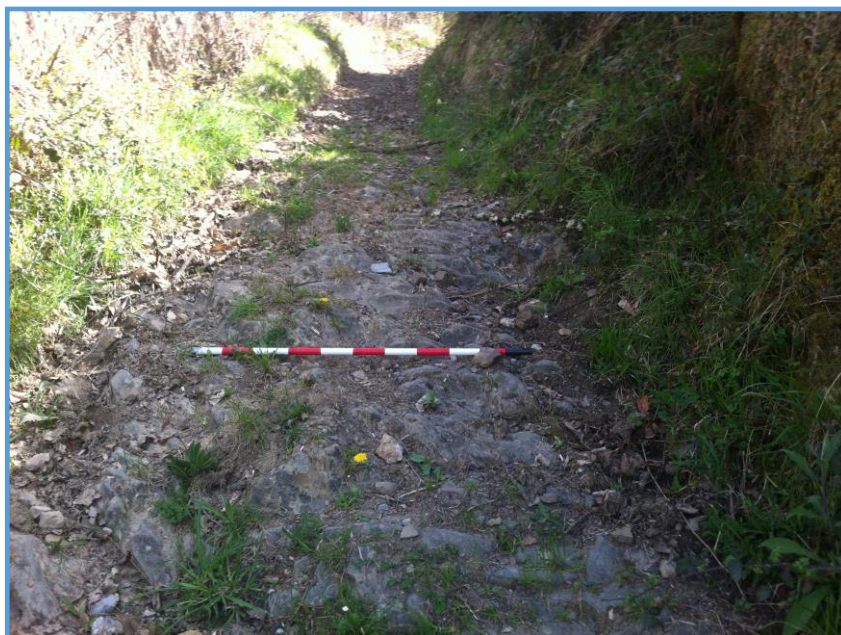
Fig. 233. Camino empedrado a su paso por Poriello
