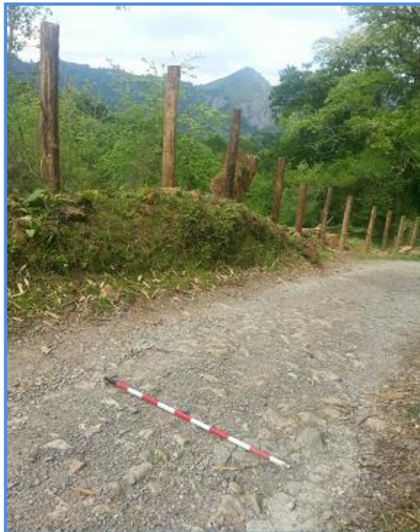
Fig. 271. Restos enlosados a su paso por Los Tocones
