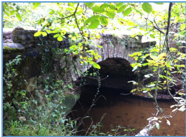
Fig. 319. Puente sobre el río Nabla
