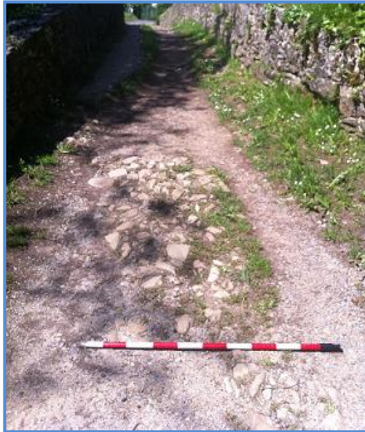
Fig. 306. Calzada del Puente de Bergueres
