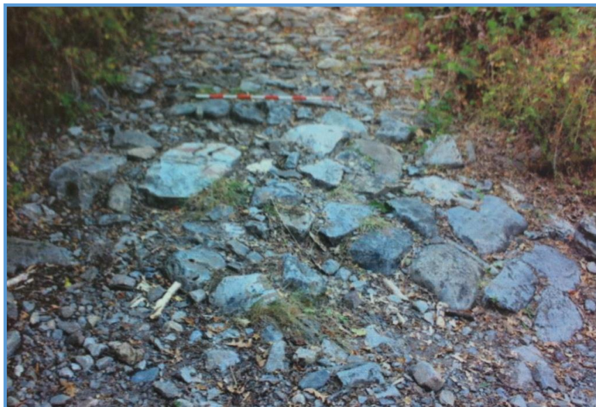
Fig. 48. Detalle del sector enlosado conservado de la calzada a su paso por Rebollar.
