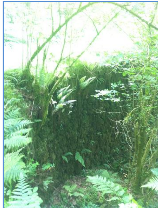
Fig. 276. Muro de contención viario
