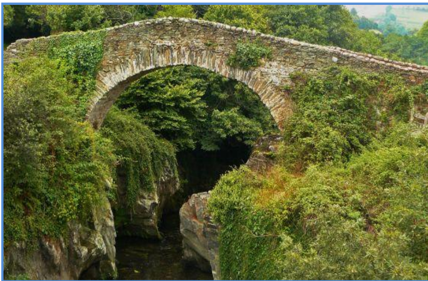
Fig.55. Puente medieval de la Regla de los Perandones
