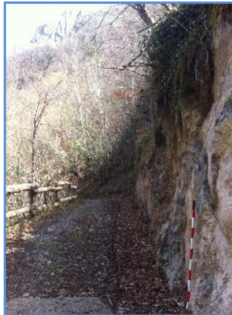
Fig. 227. Caja excavada en la roca. Talud lateral en Llaría
