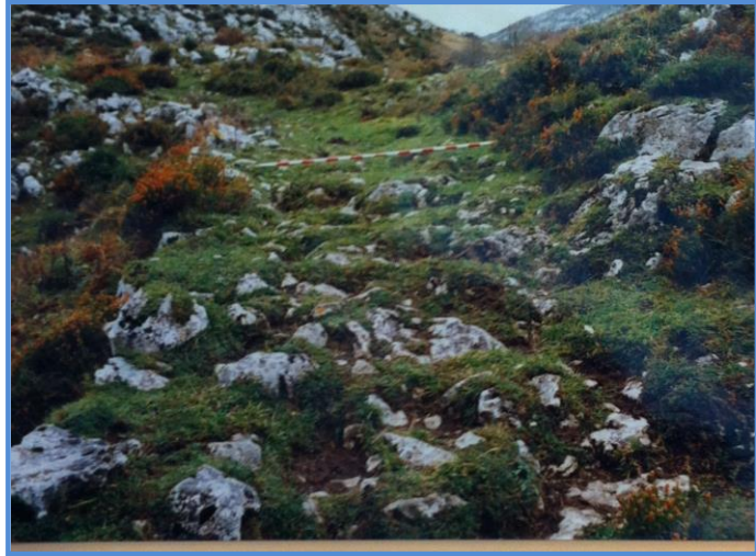
Fig. 36. Aspecto de la caja y talud de la vía en el Alto del Valle del Tameza.
