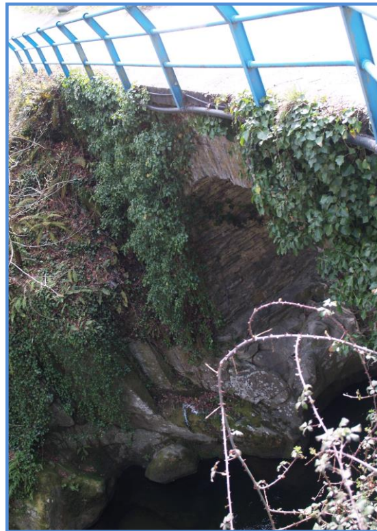
Fig. 52. Puente de La Pescal sobre el río Narcea
