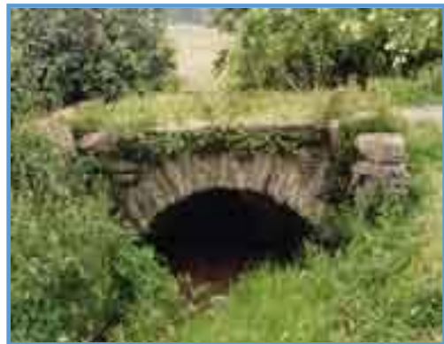
Fig. 339. Puente de Tabarcias sobre el arroyo de La Olla, Valdés.
