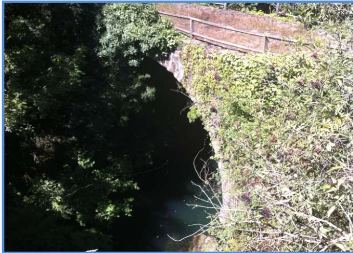
Fig. 164. Puente de Briendes, Campomanes.
