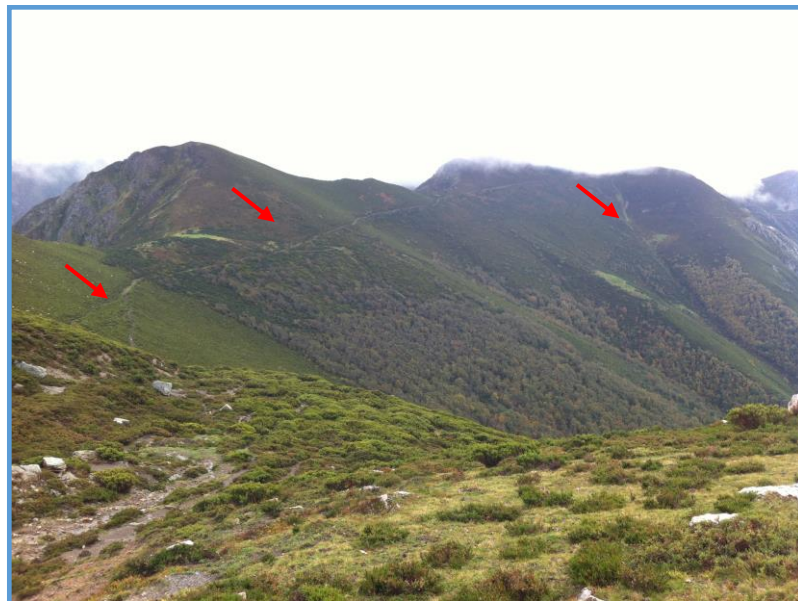
Fig. 88. Vista desde el pico Chandurrio de la vía de acceso
