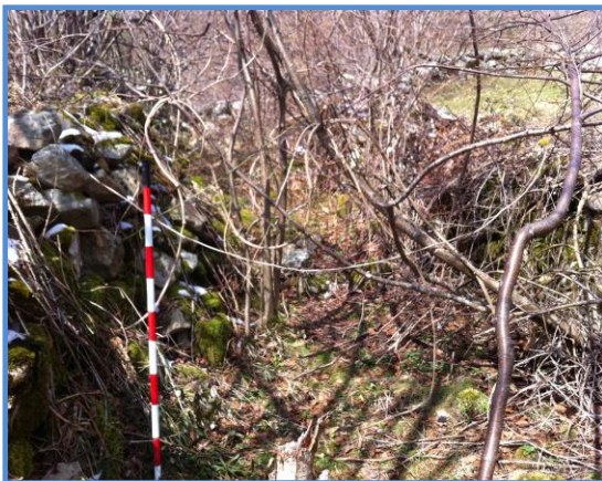
Fig. 182. Detalle del muro lateral Suroeste de la vía
