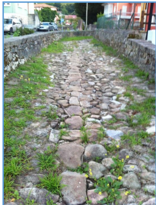
Fig. 313. Tramo de calzada en Nueva de Llanes.
