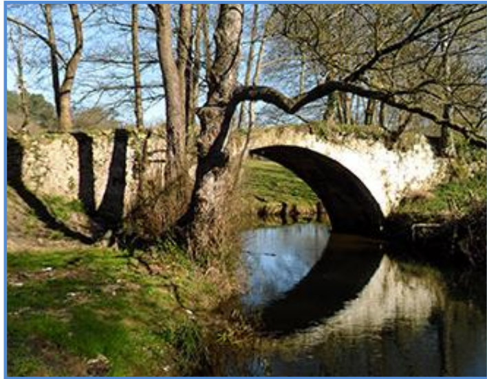
Fig. 284. Aspecto actual del Puente de Recuna
