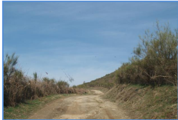
Fig. 65. Calzada dirección a la Venta de Farruquito denominada “El Caleyón”.
