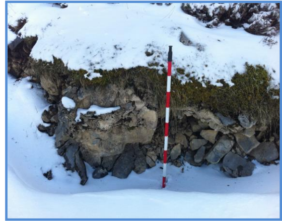
Fig. 180. Detalle del muro de contención en el margen Norte de la vía
