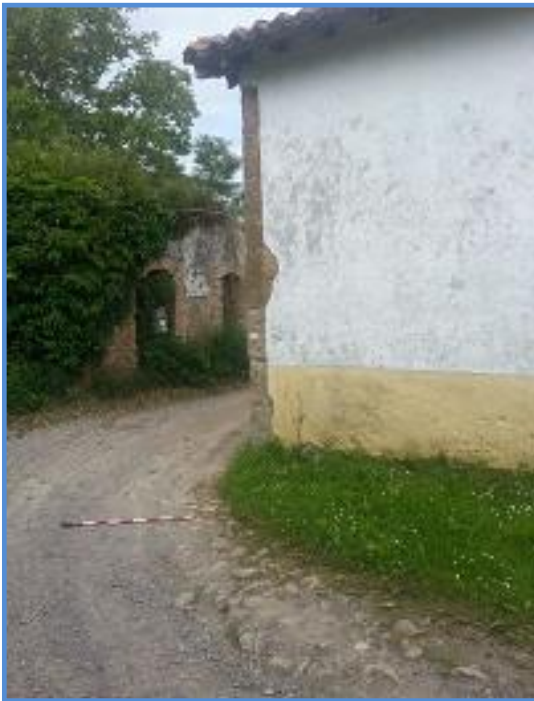
Fig. 272. Enlosado anexo a la fachada Oeste de la Ermita de San José
