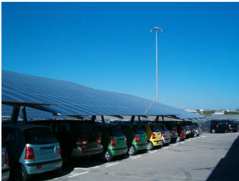
Figura 2.2: SFCCR Photocampa: Generador FV cumpliendo su función de aparcamiento.
