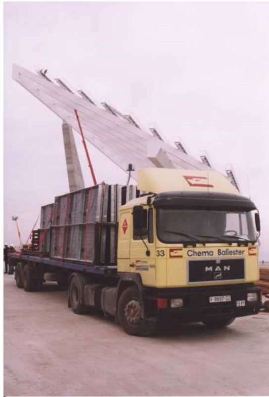
(a) Transporte en camión de módulos ensamblados en parrillas.
